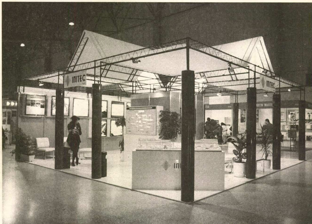
El stand de INITEC expuso las tecnologías de bajo coste para la depuración de aguas residuales.
