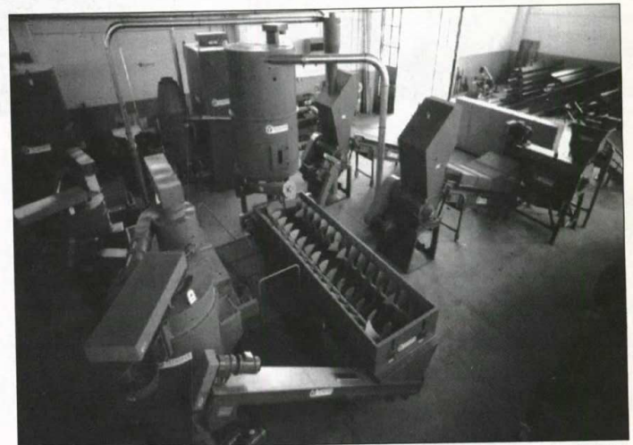
Zona de lavado y centrifuga de la planta de reciclaje de plásticos.
