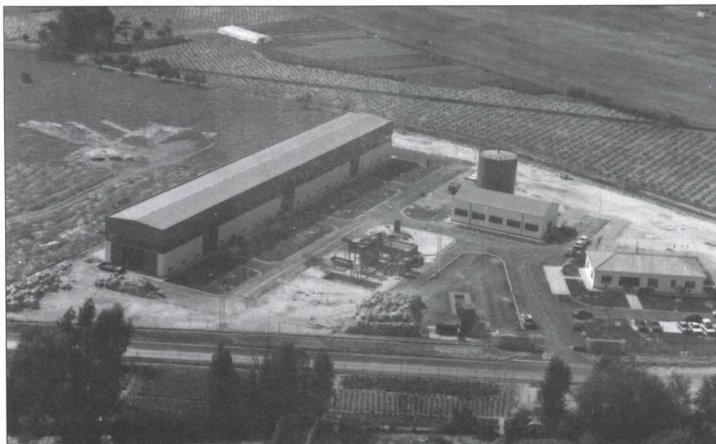
LA PLANTA DE LOS PALACIOS TIENE UNA CAPACIDAD DE TRATAMIENTO DE 5 000 TONELADAS ANUALES AMPLIABLES A 10 000.
