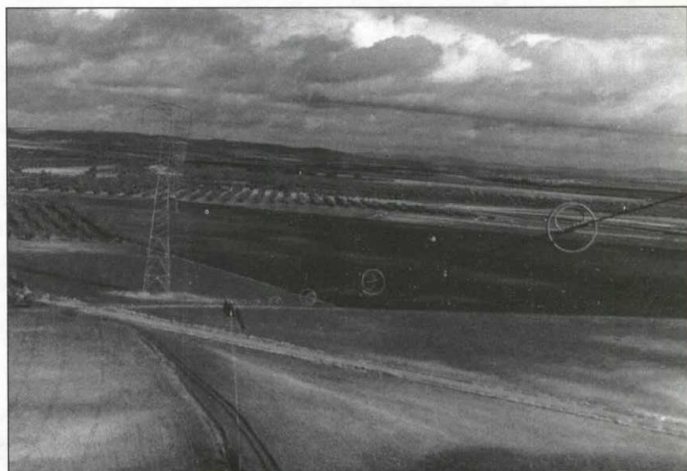
CABLES CON ESPIRALES SALVAPAJAROS DE PVC DE COLORES EN LA LINEA VALDECABALLEROS-GUILLENA.
