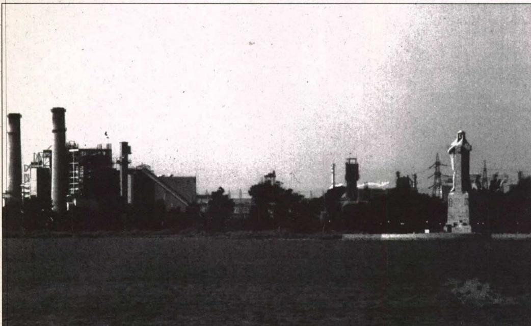
LOS VERTIDOS SIN DEPURAR PROVOCARON LA PRACTICA DESAPARICION DE LA VIDA MARINA EN LA RIA DE HUELVA DURANTE LAS PASADAS DÉCADAS
