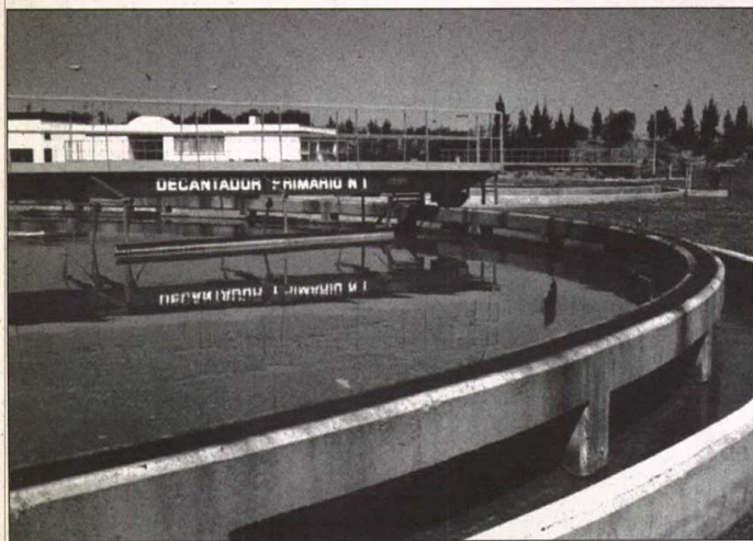
LA CONSTRUCCIÓN DE DEPURADORAS ELIMINARÁ ALREDEDOR DE 200.000 PUNTOS NEGROS DE VERTIDO
