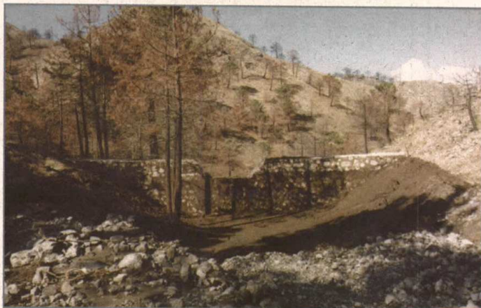
Contención de tierras arrastradas por la erosión mediante un dique de mampostería hidráulica.
