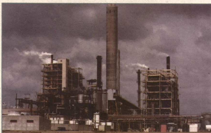
La nueva chimenea de cien metros de altura disminuye la incidencia de las emisiones malolientes.
