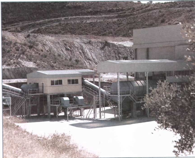
La planta de recuperación y compostaje de Vélez de Benaudalla presta servicio a más de 130.000 habitantes.
