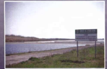
Depuradora de Lagunaje de Almonte.
