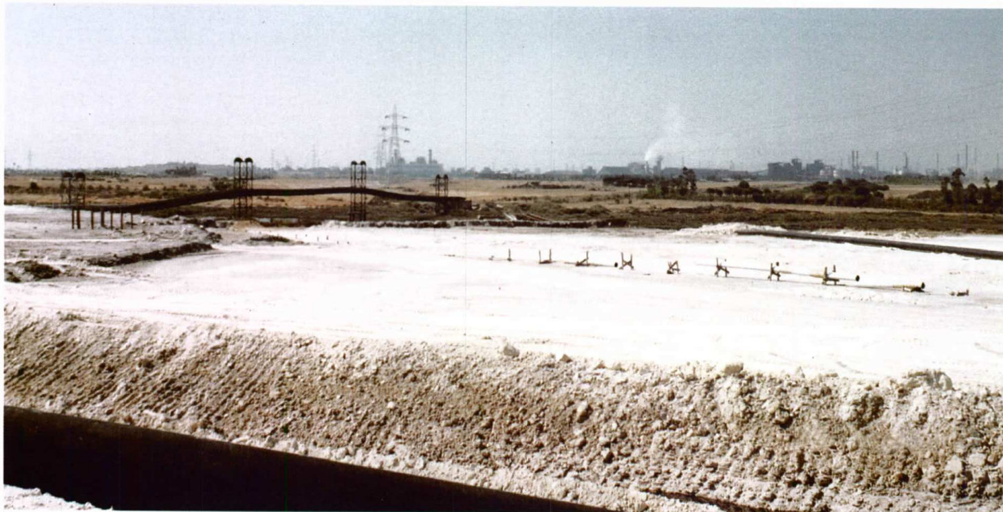
Apilamiento de yeso con restos del antiguo sistema de vertido, en el límite con las balsas que ya están restauradas.
