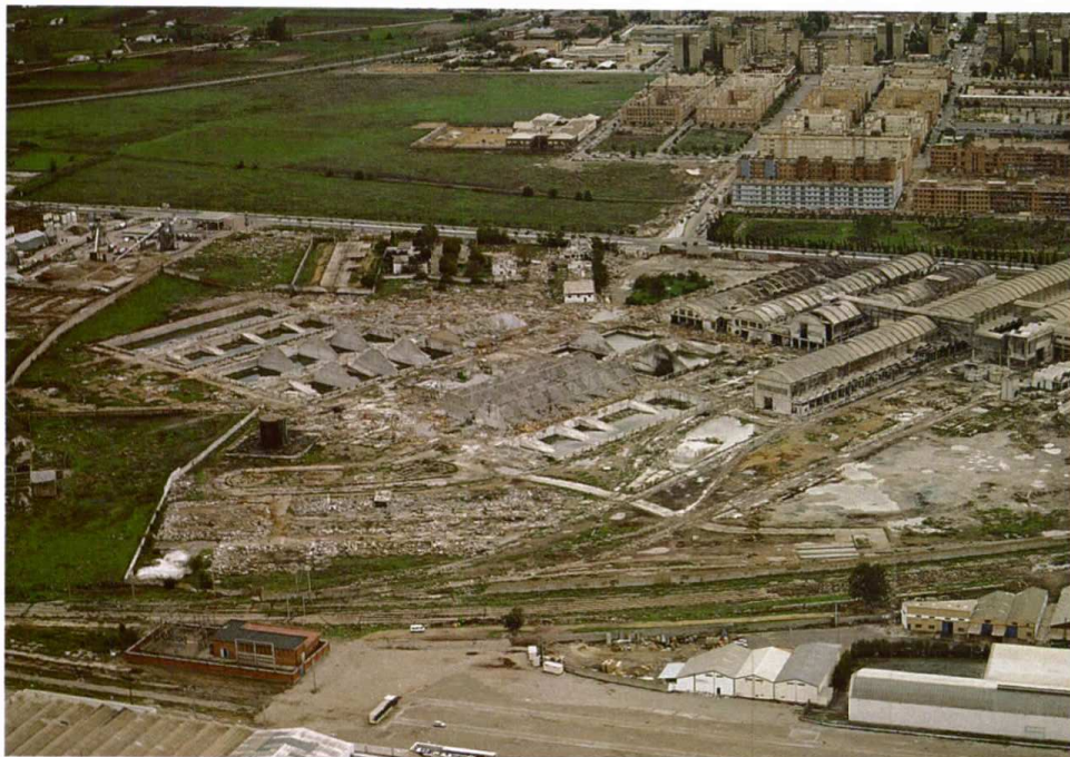
La actuación a realizar en los terrenos de FESA se harán sobre una superficie de 26.000 m 2 .
