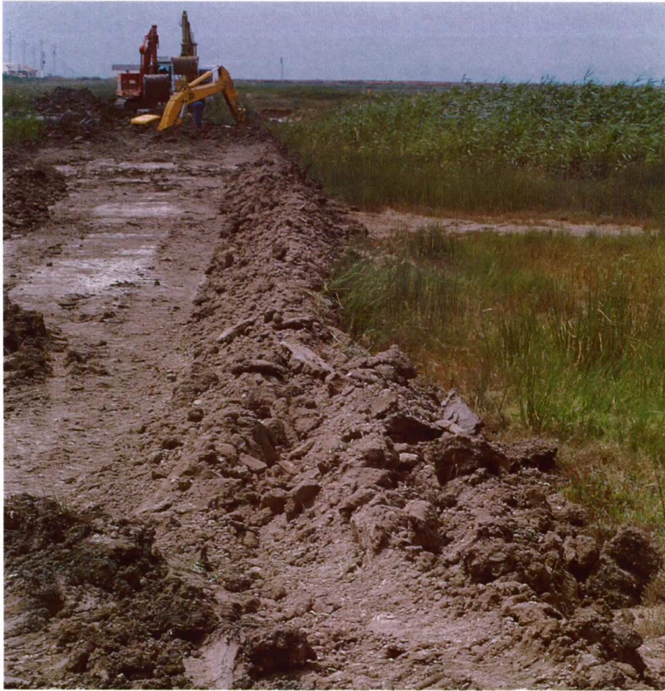
Construcción de uno de los primeros diques de contención de los vertidos procedentes de la mina.
