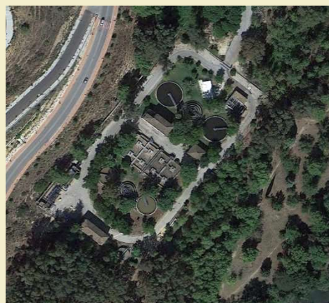
EDAR de Arcos de la Frontera.
