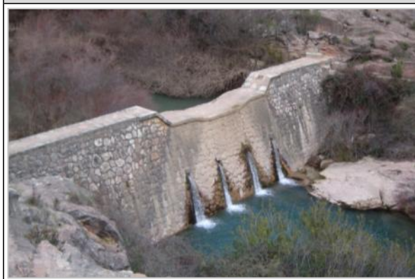
Figura 3. Dique en el tramo piscícola del río Turón
