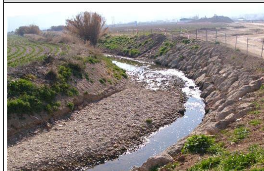
Figura 1. Río de la Villa antes de la confluencia con el río Guadalhorce
