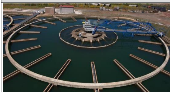
Figura 2. Estación Regeneradora de Aguas Residuales en la Costa del Sol Occidental
