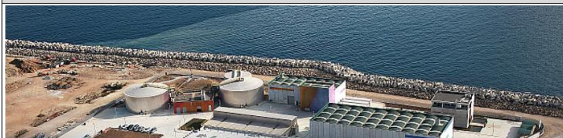
Figura 4. EDAR de Algeciras
