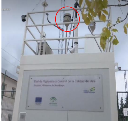
Estación de medida de la calidad del aire
