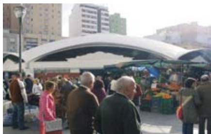
Mercado de Abastos de Algeciras, exterior
