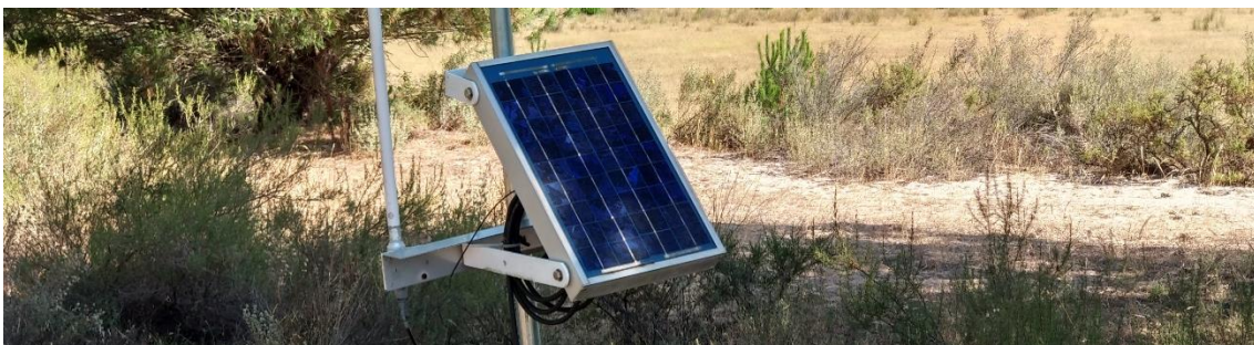
Figura 3. Instalación de nodo terminal (detalle placa de placa solar del nodo #8).
