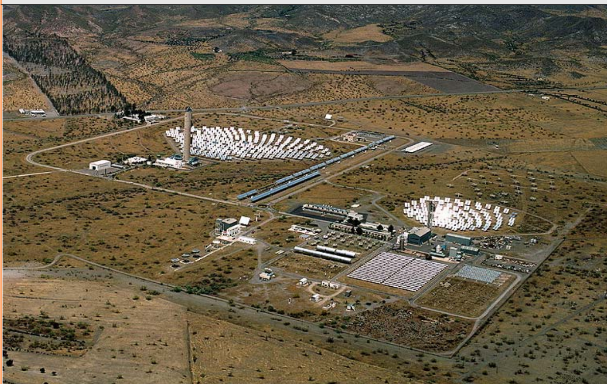
Figura 37. Vista aérea de la Planta Solar de Almería
