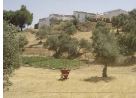
Emplazamiento en unidad de ladera con rebaje artificial del terreno.
