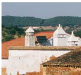
Las placas solares no deben sobresalir por encima de la cumbrera del edificio.
