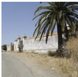
Cerramiento de protección del edificio en mampostería coronado con cubierta.
