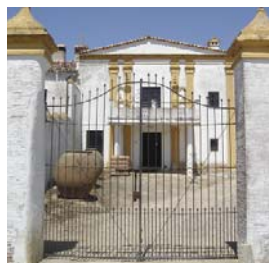
Fachada principal en la que se alternan los colores blancos y ocre.
