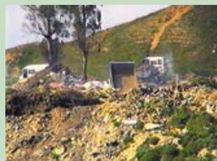
Situación inicial del vertedero
