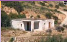
Filtros vegetales en la cubierta, como los emparrados o porches
