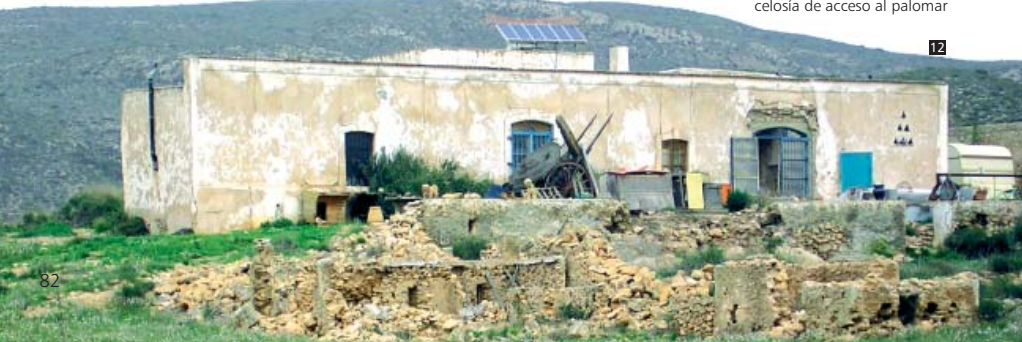
Casa del cortijo del Hornillo, se observa una celosía de acceso al palomar
