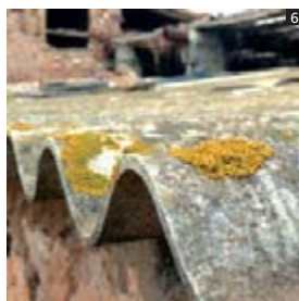
Detalle de cubiertas del cortijo Requena
