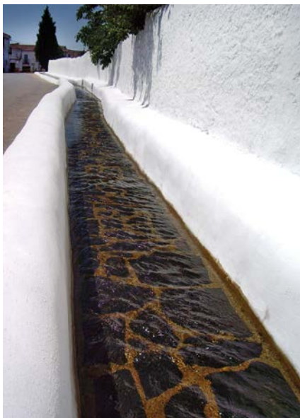
Acequia que conduce el agua a la Laguna
