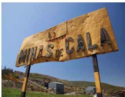
Antiguas instalaciones de Minas de Cala
