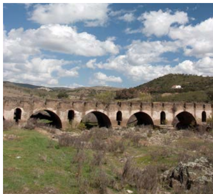
Puente sobre el Sillo, en Encinasola
