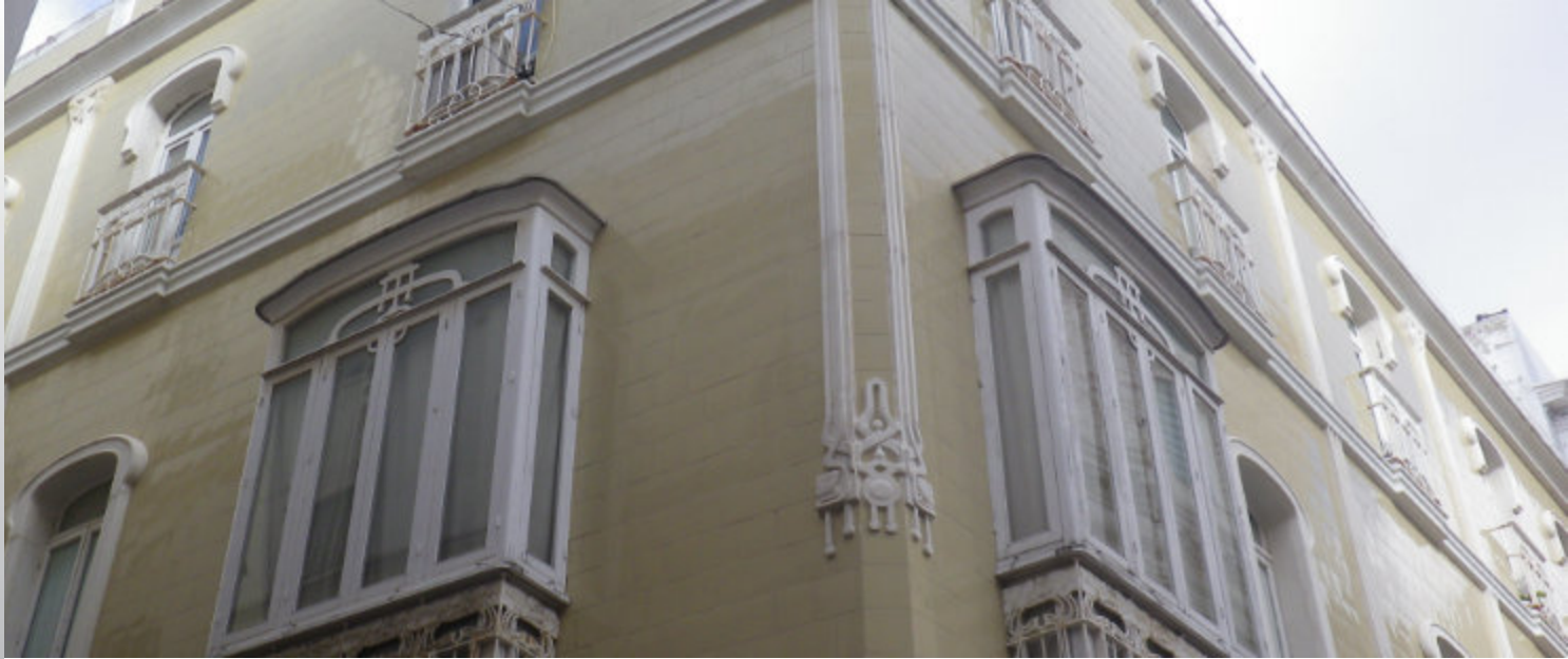
Viviendas rehabilitadas en Cádiz. P. Flores.
