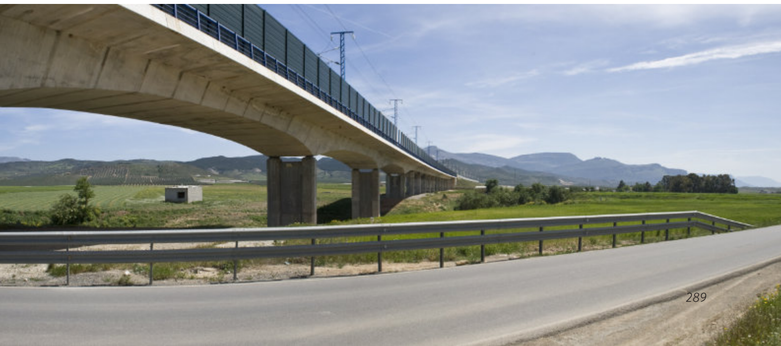
Paso elevado del AVE cerca de Bobadilla. Málaga.
