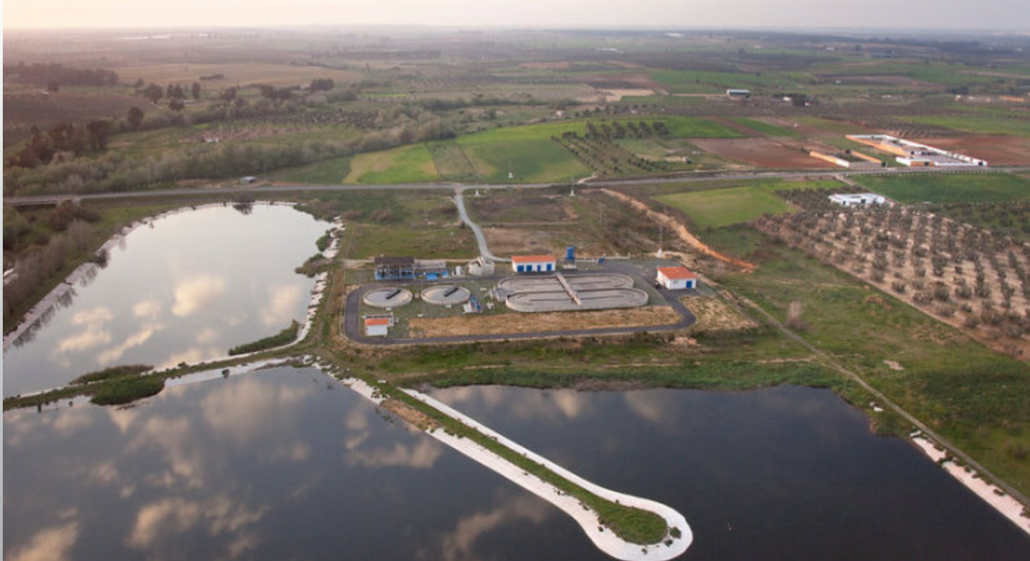
Depuración de aguas. Mazagón - Almonte (Huelva). J. Hernández.
