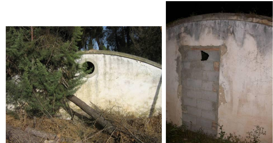
Cara oeste del Aljibe de los Bermejales (foto izda.). En la foto de la derecha la cara este del aljibe, antigua puerta que daba acceso al interior actualmente tapada con muro de obra.
