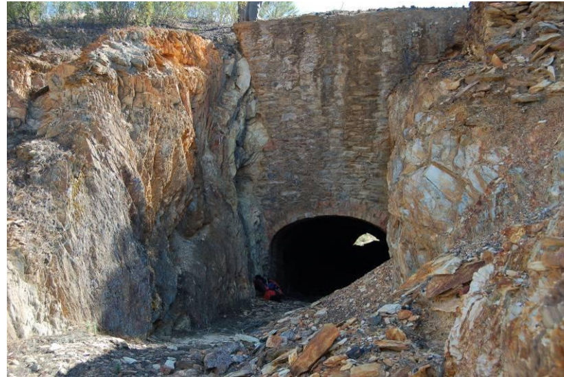
Entrada este del túnel de la mina Campanario.
