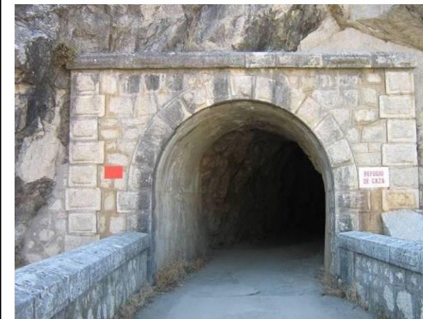
El túnel de la Carretera está ubicado en las inmediaciones de la Presa del Jándula, por el que atraviesa una pista que permite el acceso a los operarios de la presa además, sirve para dar paso a los propietarios del coto de caza.
