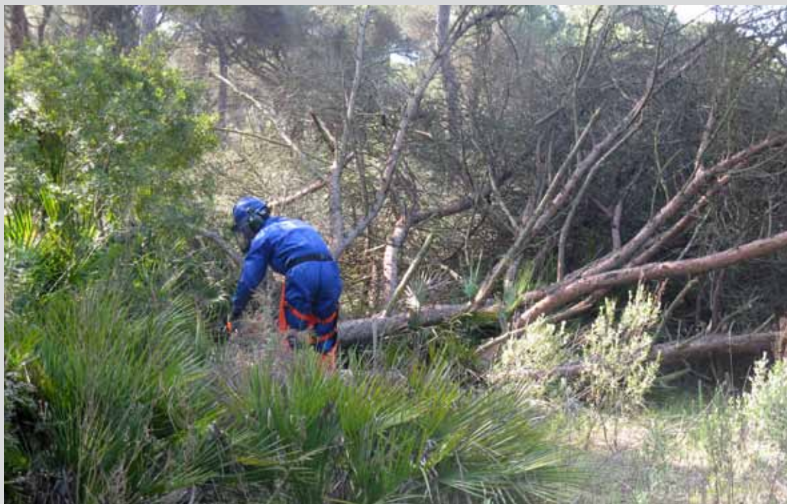
Trabajador realizando el apeo de pino piñonero en el término municipal de Cartaya. (Obra 05_HU_226_5_2. Proyecto de actuaciones selvícolas y de prevención de incendios en los términos municipales de Moguer y Cartaya).
