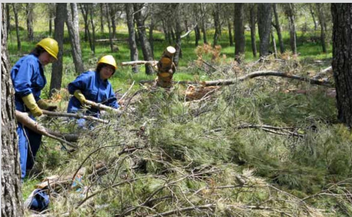
Cuadrilla de peones forestales apilando residuos en el T.M. Archidona (Málaga). (Obra 07_MA_226_5_2. Manejo del alcornocal en montes del T.M. Cortes de la Frontera y TT.SS. preventivos en montes de Málaga y aledaños).
