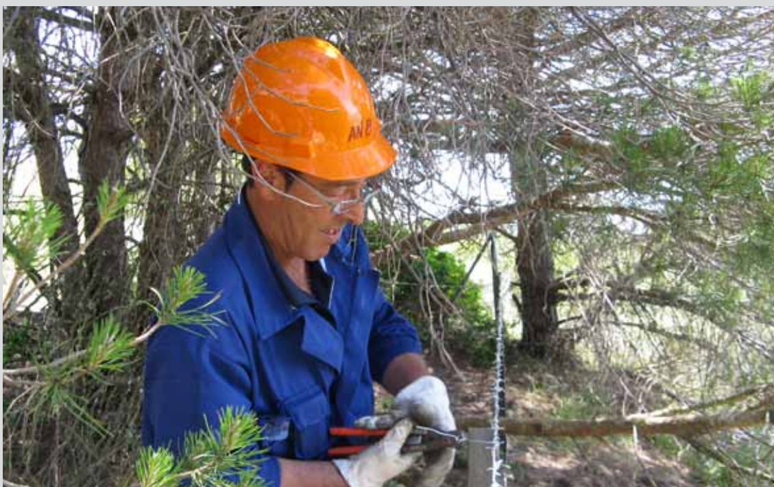
Peón forestal colocando cerramiento de malla de alambre en el T.M. Barbate (Cádiz). (Obra 02_CA_226_5_5. Actuaciones selvícolas de prevención de incendios, de mejora productora, de corrección hidrológica y restauración en montes Públicos de Barbate).
