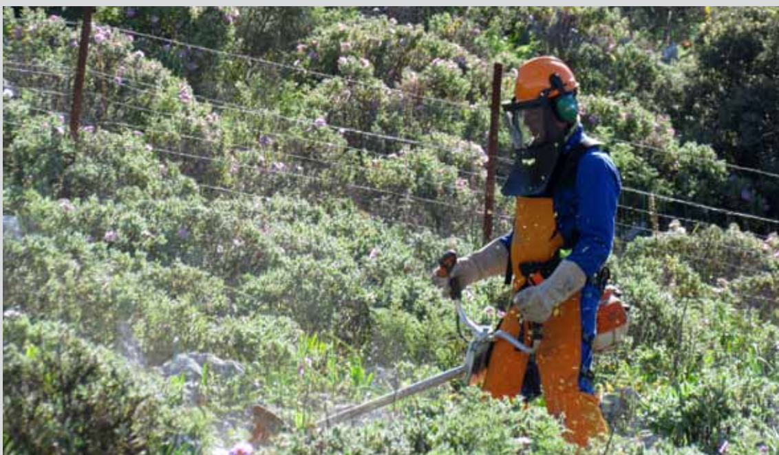
Operario realizando desbroce con motodesbrozadora en el T.M. Ubrique (Cádiz). (Obra 02_CA_226_123_2. Actuaciones selvícolas de prevención de incendios, de mejora productora, de corrección hidrológica y restauración en montes públicos de el Gastor, Paterna y otros).
