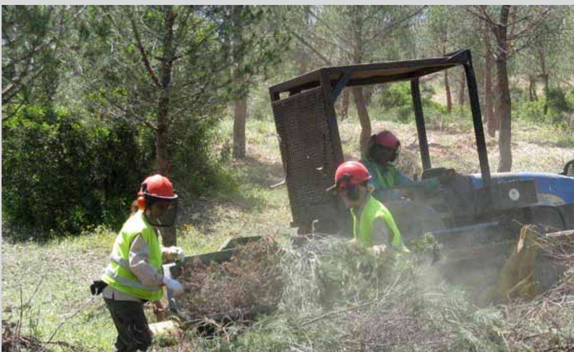
Astillado de residuos con astilladora propulsada por tractor oruga y alimentada por dos peones en el T.M. Chiclana de Segura (Jaén).
