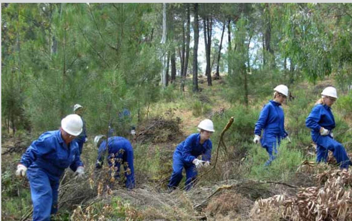
Cuadrilla de trabajadores apilando restos de corta en el T.M. Villaviciosa de Córdoba (Córdoba). (Obra 03_CO_226_5_2 Tratamientos selvícolas preventivos para la mejora de la masa en el grupo de montes públicos de Villaviciosa).
