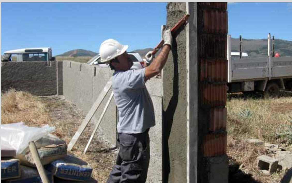
Enfoscado y enlucido con mortero de fábrica de ladrillo en el T.M. Canjáyar (Almería). (Obra 01_AL_323_2 Contrato menor "Aprisco de Ganado").
