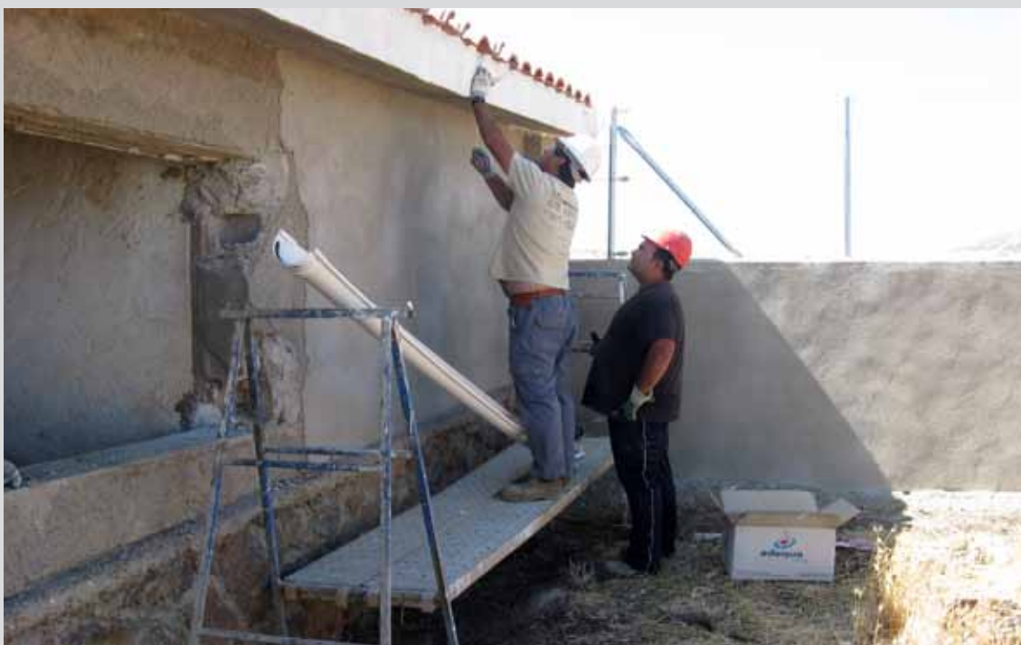
Trabajadores realizando trabajos de fontanería en el T.M. Canjáyar. (Obra 01_AL_323_2 Contrato menor "Aprisco de Ganado").
