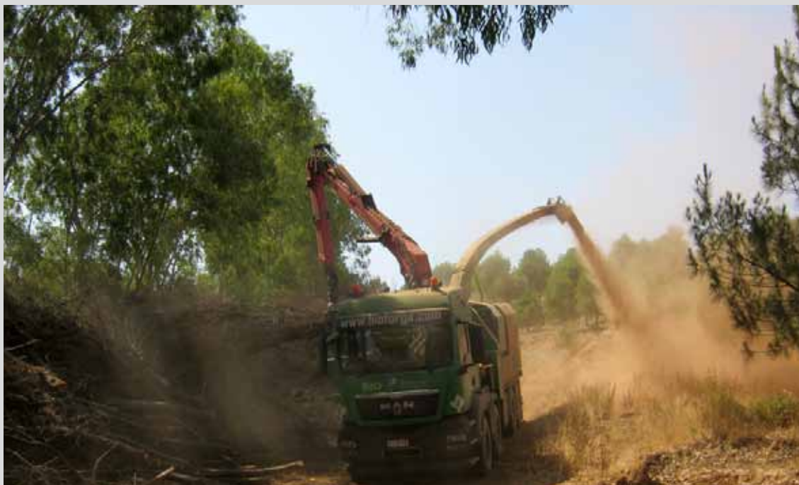
Camión-Astilladora astillando pinos en el T.M. El Ronquillo (Sevilla). (Obra 08_SE_226_123_2 Actuaciones selvícolas de prevención de incendios en los montes públicos de El Madroño, El Castillo de las Guardas, El Ronquillo y el Corredor Verde del Guadiamar).
