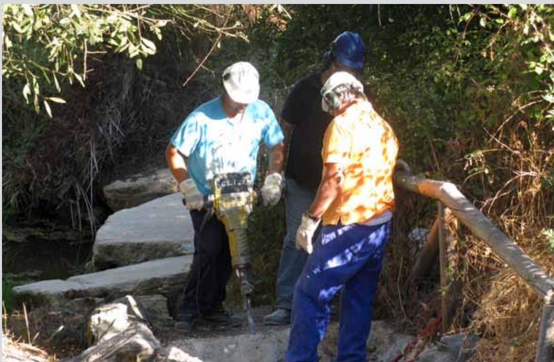
*Operarios realizando trabajos de picado y demolición de solera en el T.M. Moguer (Huelva).
