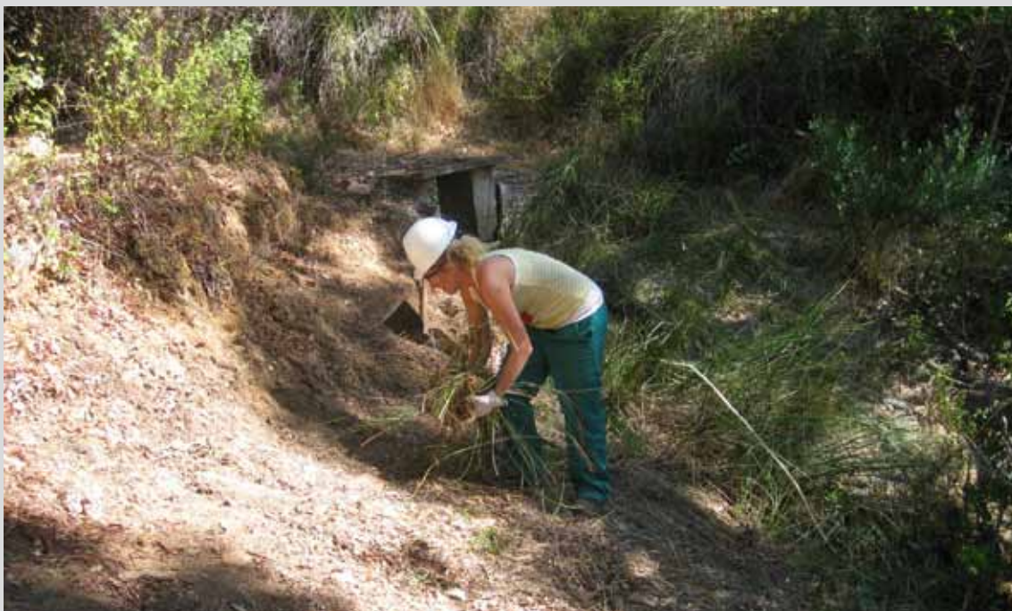
Peón forestal realizando desbroce y excavación manual en el T.M. Zalamea La Real (Huelva). (Obra 05_HU_323_1 Proyecto de restauración, mejora y puesta en valor del patrimonio rural en montes públicos de la provincia de Huelva).
