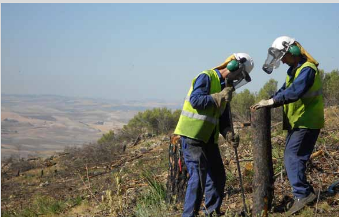
Cuadrilla de trabajadores realizando construcción de fajinas en el T.M. Montellano (Sevilla). (Obra 08_SE_226_5_2 Actuaciones selvícolas de prevención de incendios y restauración en los montes de Montellano).
