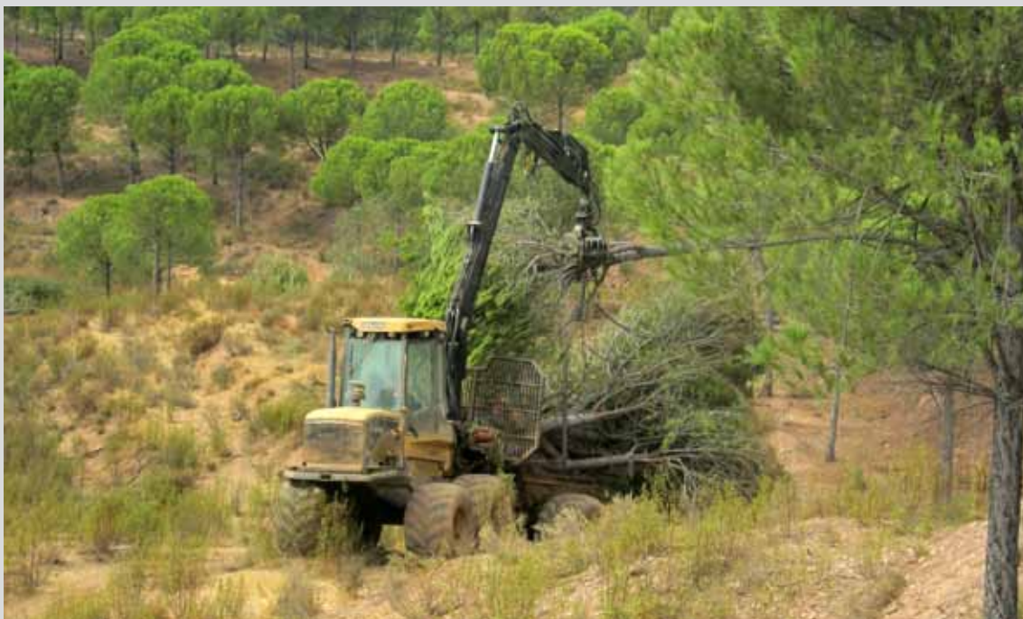
Autocargador sacando pinos apeados a la zona de astillado en el T.M. Aznalcóllar (Sevilla). (Obra 08_SE_226_4_1 Actuaciones selvícolas de prevención de incendios y de mejora productora en los montes públicos de Madroñalejo y Dehesa del Perro del T.M. de Aznalcollar. (Sevilla)).
