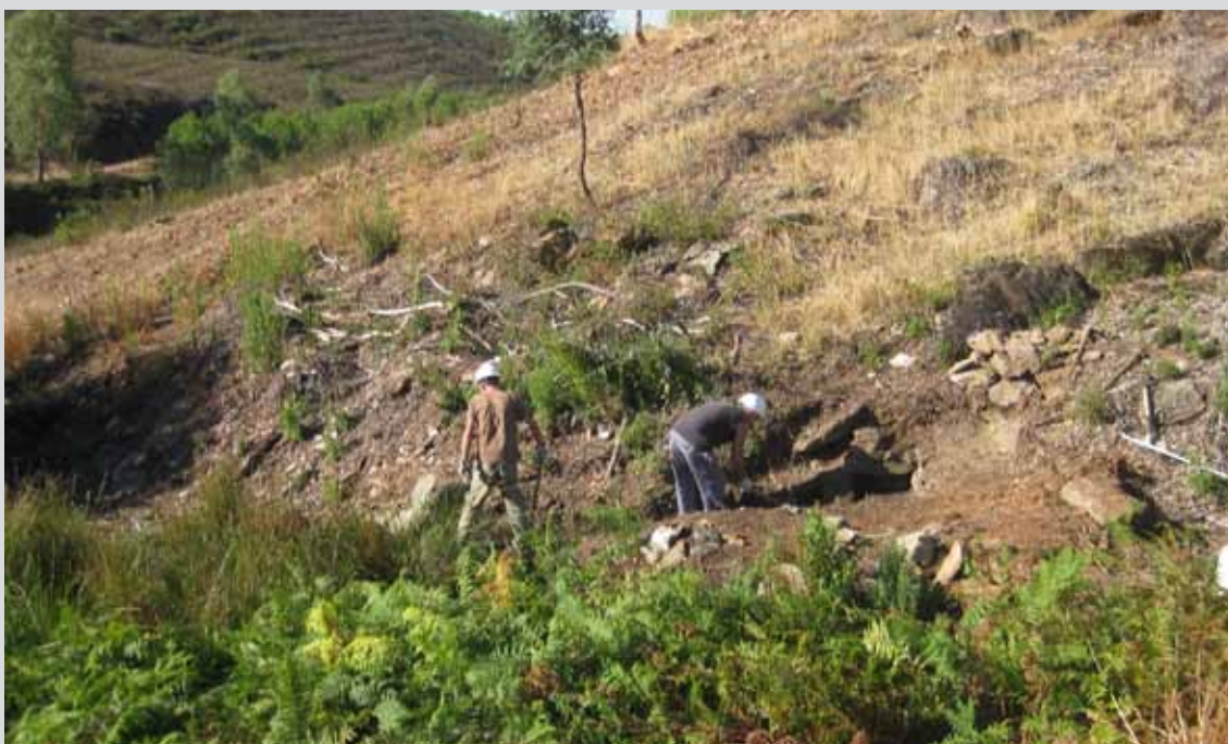
Peones forestales realizando desbroce y excavación manual en el T.M. Valverde del Camino (Huelva). (Obra 05_HU_323_1 Proyecto de restauración, mejora y puesta en valor del patrimonio rural en montes públicos de la provincia de Huelva).
