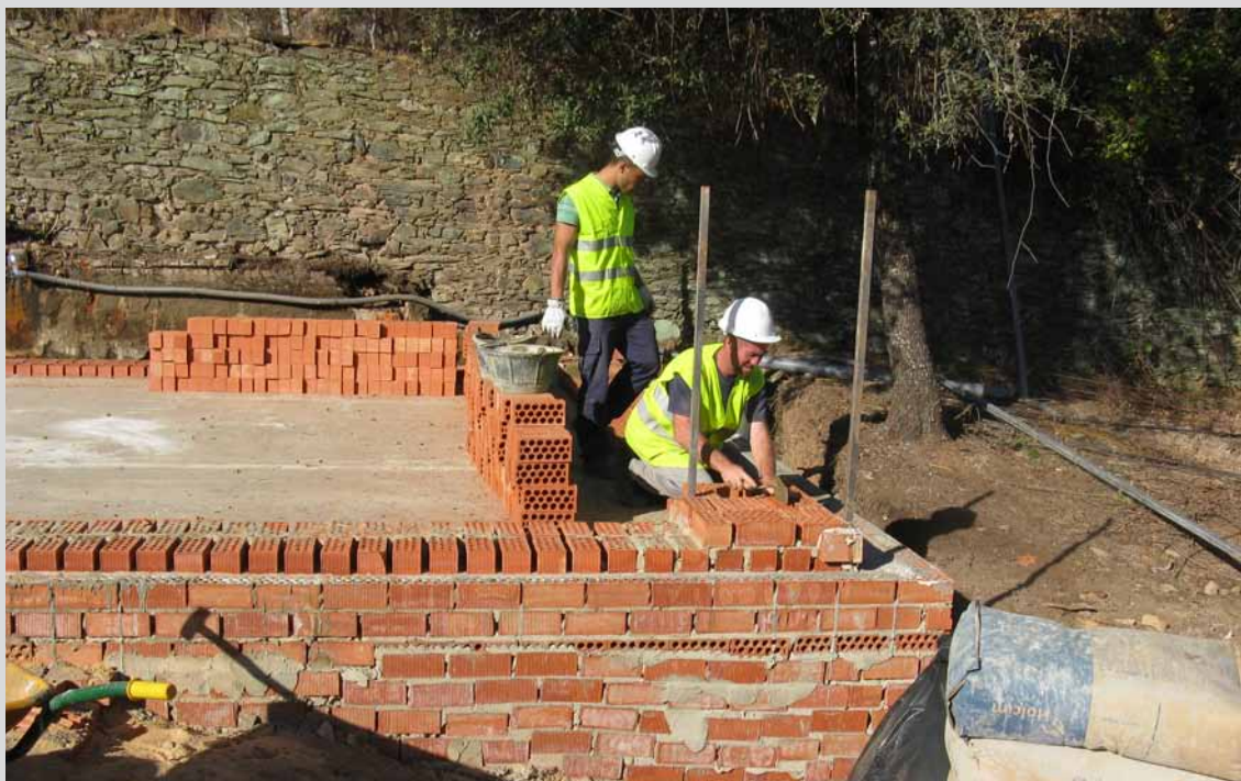
Cuadrilla de operarios realizando trabajos de albañilería en el T.M. Calañas (Huelva). (Obra 05_HU_323_1 Proyecto de restauración, mejora y puesta en valor del patrimonio rural en montes públicos de la provincia de Huelva).
