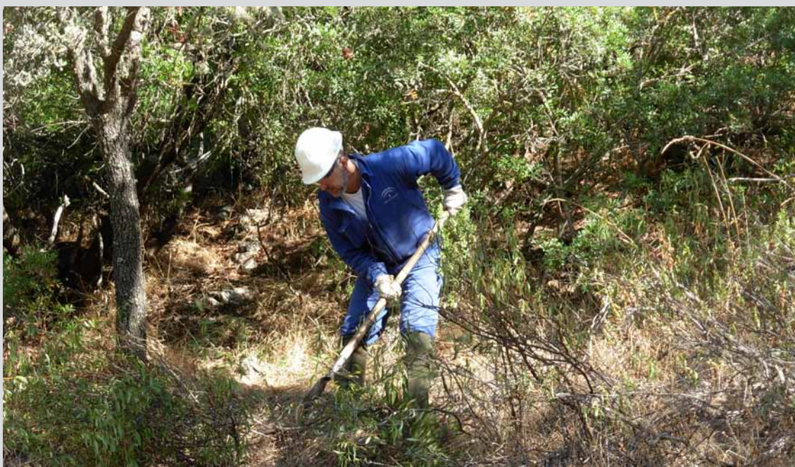
Peón forestal realizando roza manual en el T.M. Hornachuelos (Córdoba). (Obra 03_CO_226_5_3 Tratamientos selvícolas preventivos para la mejora de la masa en el grupo de montes públicos de Hornachuelos).
