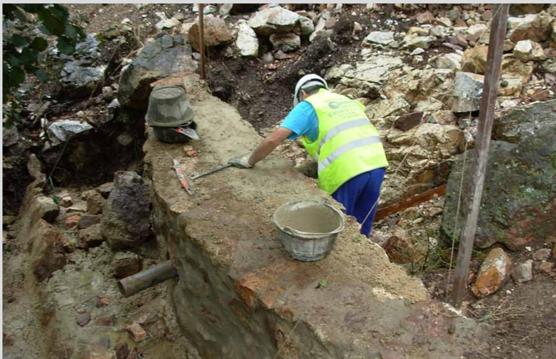
Operario realizando trabajos de albañilería en el T.M. Santa Elena (Jaén). (Obra 06_JA_323_2 Mejora del patrimonio rural en el “Parque Natural de Despeñaperros”).
