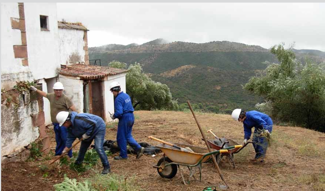
Cuadrilla de operarios realizando trabajos de limpieza manual en el T.M. Montoro (Córdoba). (Obra 03_CO_323_1 Proyecto de restauración, mejora y puesta en valor del patrimonio rural en montes públicos de la provincia de Córdoba).
