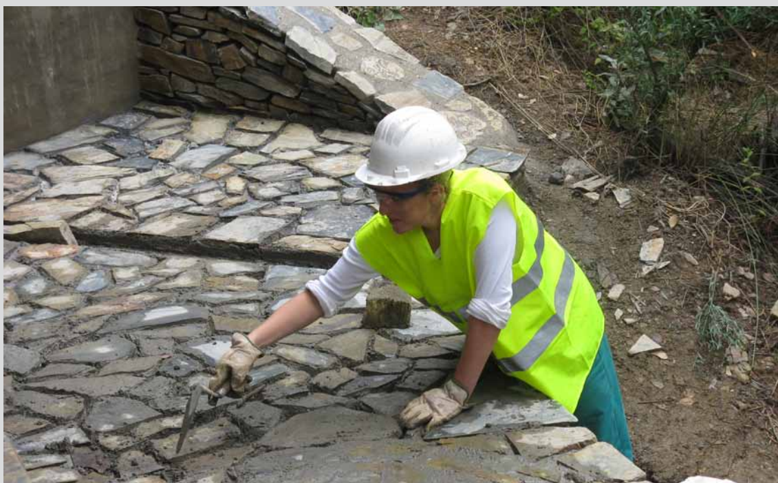
Operaria realizando trabajos de albañilería en un dique en el T.M. Zalamea la Real (Huelva). (Obra 05_HU_323_1 Proyecto de restauración, mejora y puesta en valor del patrimonio rural en montes públicos de la provincia de Huelva).
