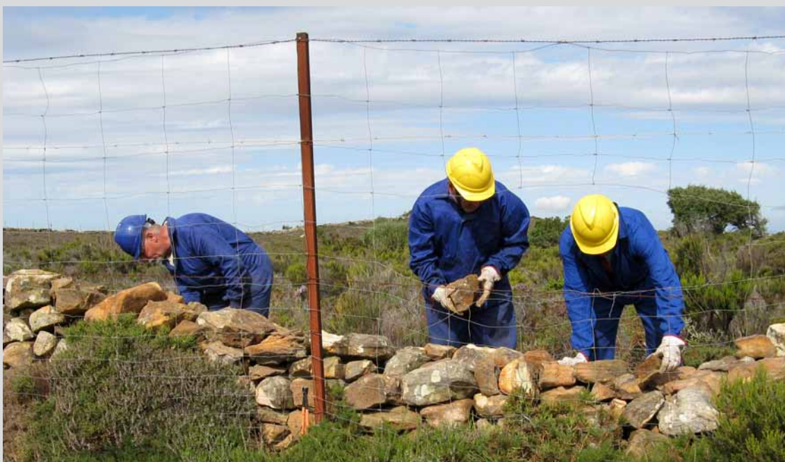
Cuadrilla de operarios realizando obra de mampostería en el T.M. Tarifa (Cádiz). (Obra 02_CA_323_1 proyecto de restauración, mejora y puesta en valor del patrimonio rural en montes públicos de la provincia de Cádiz).
