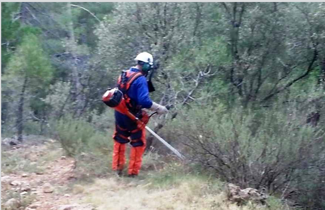
Operarios desbrozando con motodesbrozadora en el T.M. Cazorla (Jaén). (Obra 06_JA_226_5_3 Acondicionamiento de infraestructuras de prevención de incendios forestales en el "P.N. Cazorla, Segura y las Villas").
