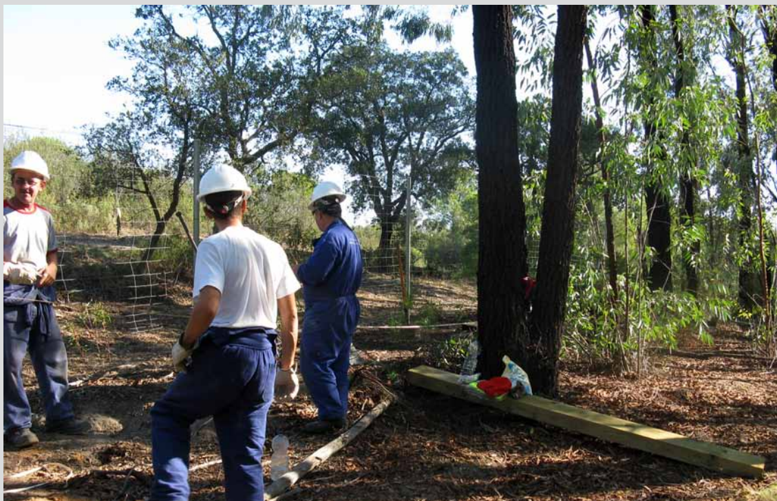
Cuadrilla de operarios colocando vallado con malla de alambre en el T.M. Bonares (Huelva). (Obra 05_HU_323_1 Proyecto de restauración, mejora y puesta en valor del patrimonio rural en montes públicos de la provincia de Huelva).
