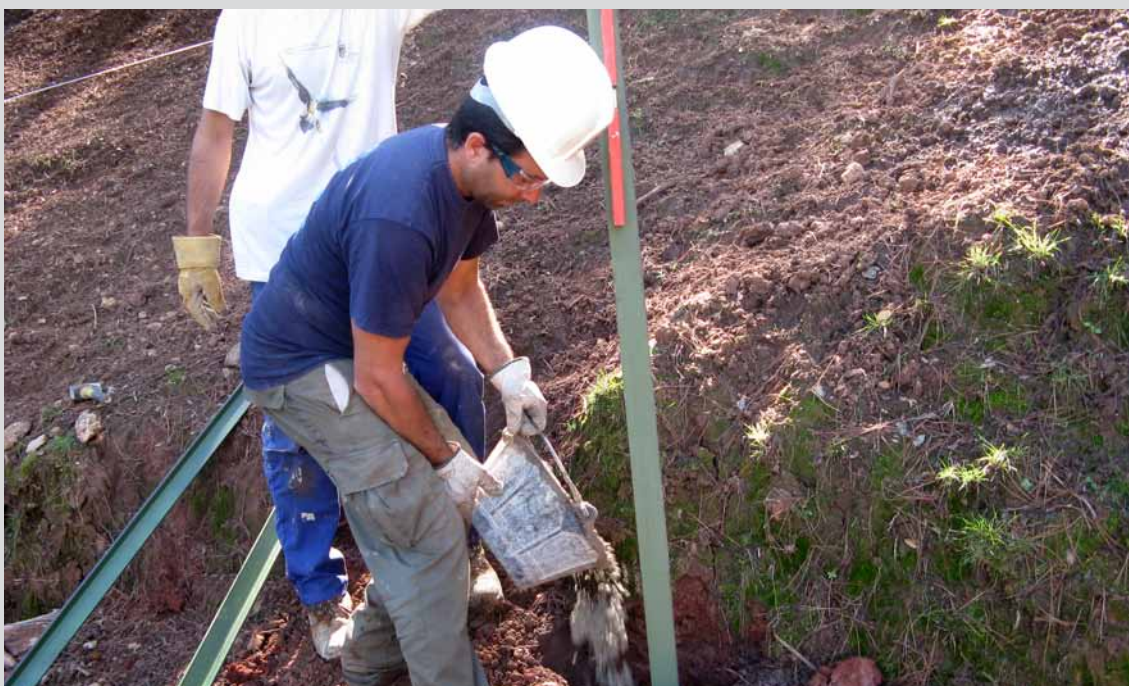
Operarios colocando postes para cerramiento con malla de alambre en el T.M. Hornos (Jaén). (Obra 06_JA_227_123_2 Actuaciones de mejora de infraestructuras de uso público y mejora de aprovechamiento cinegético en el centro de fauna silvestre "Collado Almendral" en el "P.N. Cazorla, Segura y Las Villas ")
