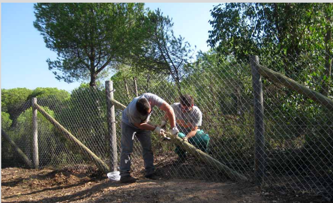
Operarios reparando cerramiento con malla alambre en la Laguna de El Portil T.M. Punta Umbría (Huelva). (Obra 05_HU_227_123_4 Actuaciones para la conservación de los hábitats en la Laguna de el Portil).
