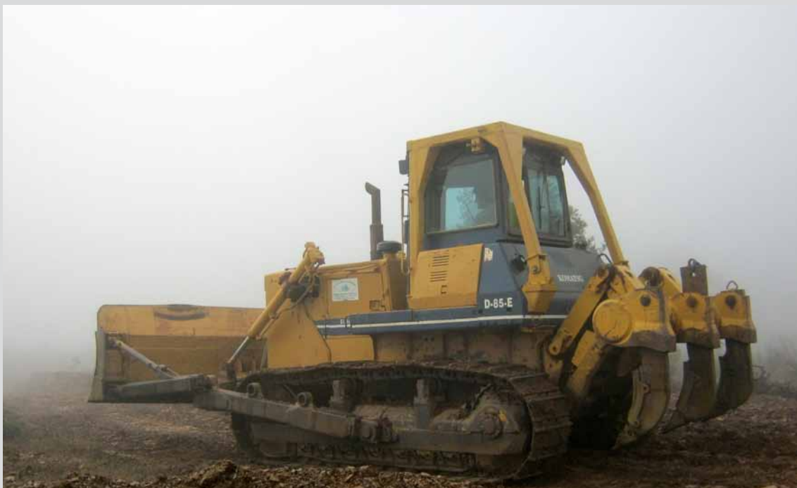
Buldozer realizando decapado y subsolado con ripper en el T.M. Aznalcóllar (Sevilla). (Obra 08_SE_226_4_1 Actuaciones selvícolas de prevención de incendios y de mejora productora en los montes públicos de Madroñalejo y Dehesa del Perro del T.M. de Aznalcóllar. Sevilla).
