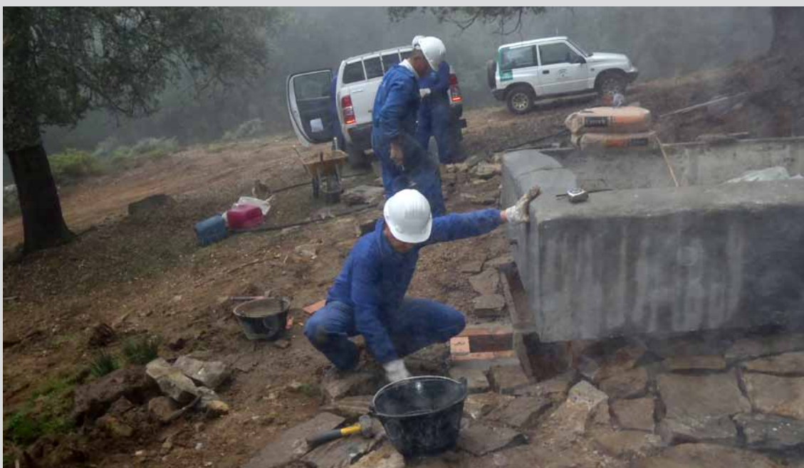
Cuadrilla de operarios construyendo un abrevadero en el T.M. Cortes de la Frontera (Málaga). (Obra 07_MA_323_1 Proyecto de restauración, mejora y puesta en valor del patrimonio rural en montes públicos de la provincia de Málaga).
