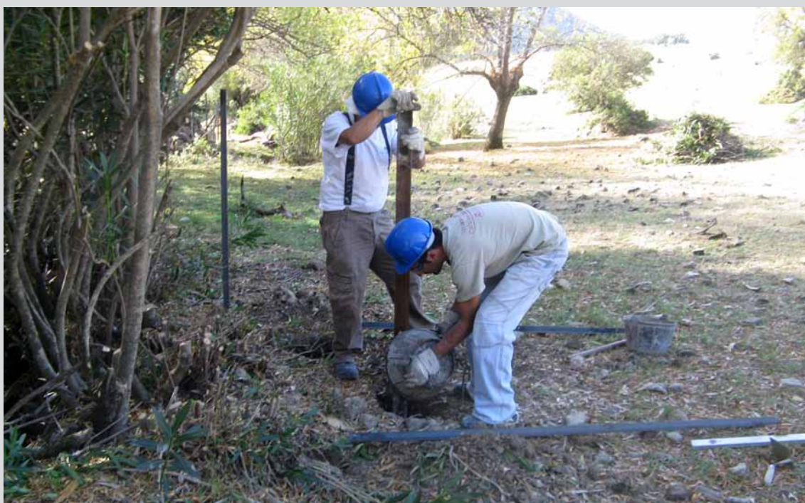
Cuadrilla de operarios realizando vertido de hormigón en masa para cimentación de postes metálicos en el T.M. Grazalema (Cádiz). (Obra 02_CA_323_2 Propuesta de adecuación y mejora de las infraestructuras ganaderas del monte de propios campo de las Encinas y los Laureles).
