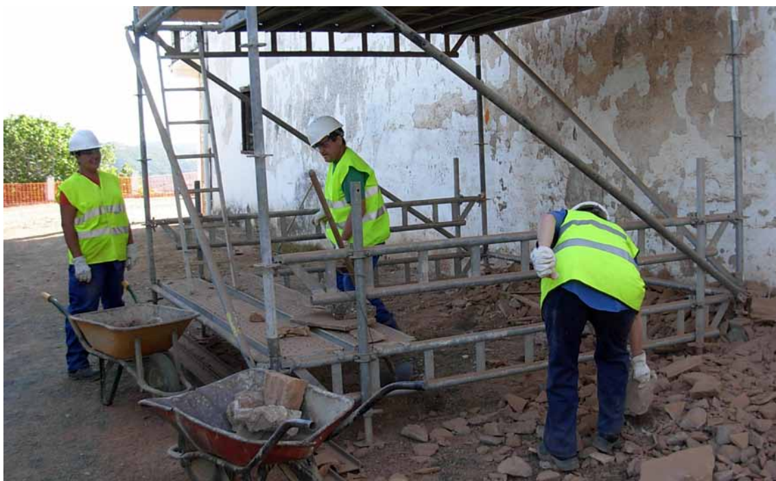
Cuadrilla de operarios realizando trabajos de albañilería en el T.M. Montoro (Córdoba). (Obra 03_CO_323_1 Proyecto de restauración, mejora y puesta en valor del patrimonio rural en montes públicos de la provincia de Córdoba).
