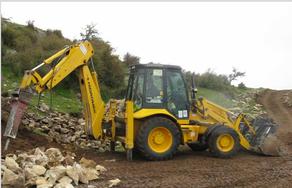
Retropala extrayendo material para aprisco en el T.M. Castril (Granada). (Obra 04_GR_323_1 Proyecto de restauración, mejora y puesta en valor del patrimonio rural en montes públicos de la provincia de Granada).
