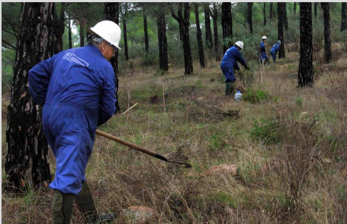
Cuadrilla de peones forestales realizando roza manual en el T.M. de Villaviciosa de Córdoba (Córdoba).
