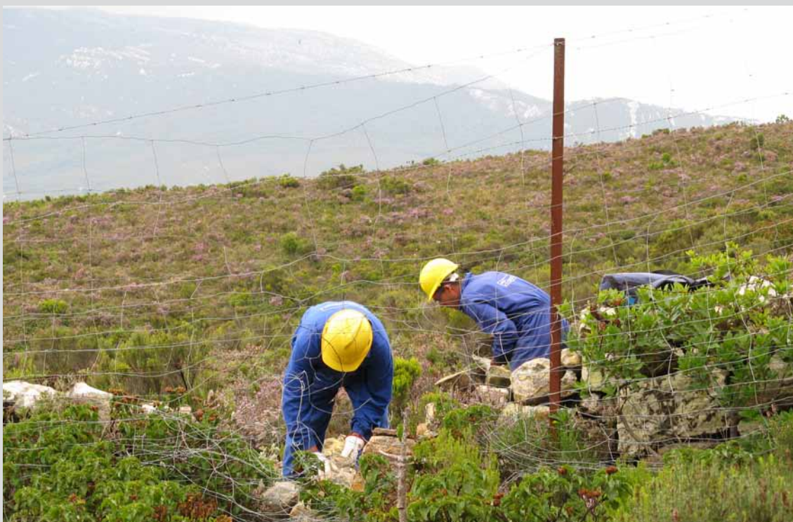
Cuadrilla de trabajadores realizando obra de mampostería seca en el T.M. Tarifa (Cádiz). (Obra 02_CA_323_1 proyecto de restauración, mejora y puesta en valor del patrimonio rural en montes públicos de la provincia de Cádiz).
