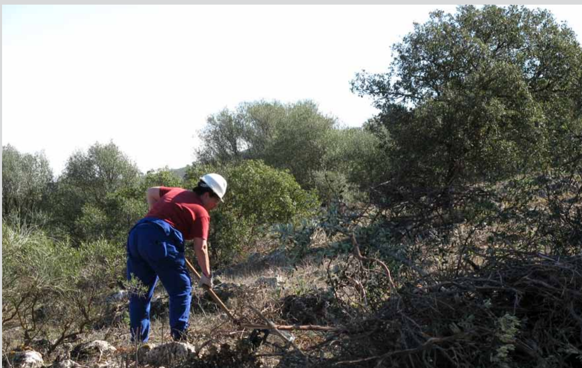
Trabajadora apilando residuos en el T.M. Pedrera (Sevilla). (Obra 08_SE_226_4_2 Actuaciones selvícolas de prevención de incendios en los montes públicos de Morón de la Frontera, los Corrales y Pedrera).
