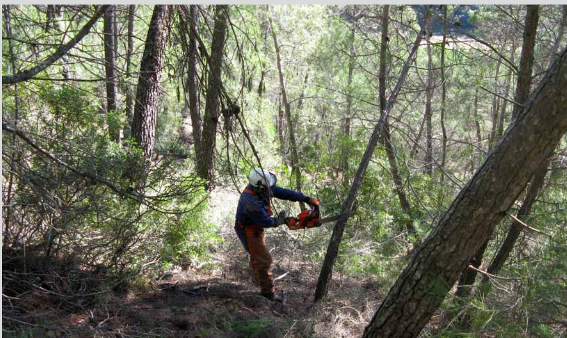
Clareo de pinar en el T.M. Santiago-Pontones (Jaén). (Obra 06_JA_226_5_3 Acondicionamiento de infraestructuras de prevención de incendios forestales en el "PN Cazorla, Segura y las Villas").
