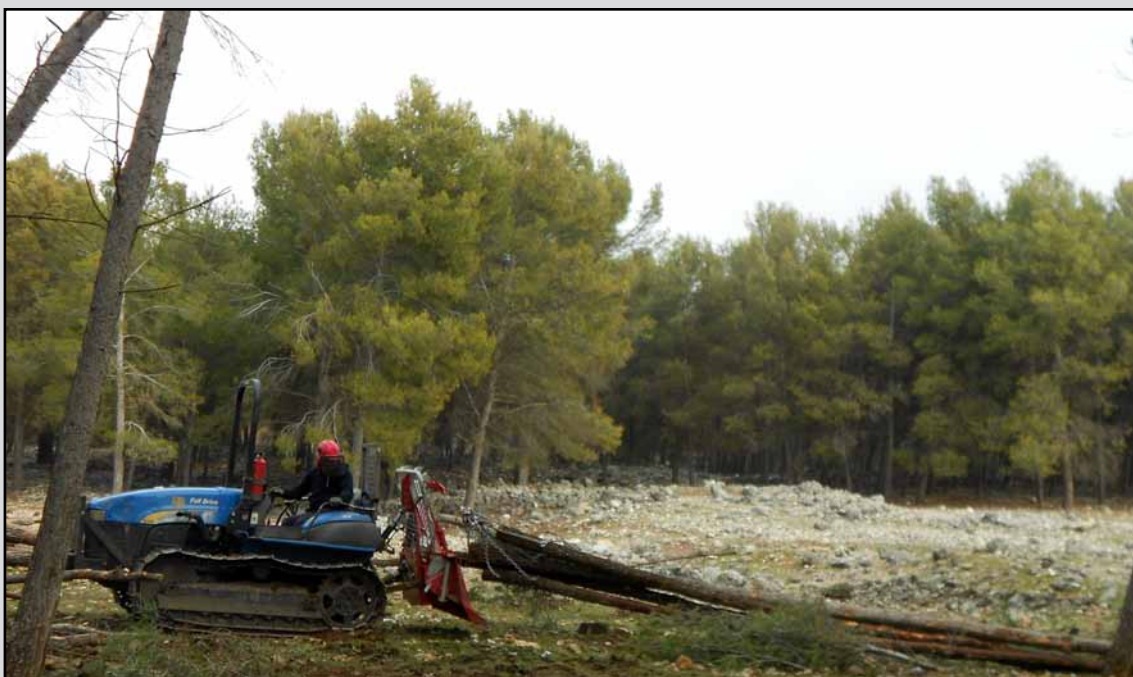
Saca de madera con cabrestante forestal en el T.M. Illora (Granada). (Obra 04_GR_226_5_2 TT.SS. de prevención de incendios forestales y de mejora de la capacidad productora de biomasa forestal de uso energético y de pastos en TT.MM. de las comarcas de Alhama, Los Montes y Loja en provincia de Granada).
