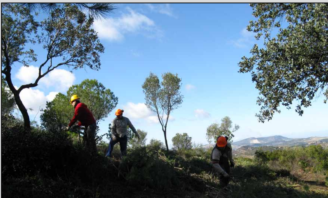
Recogida y apilado de residuos en el T.M. Coripe (Sevilla). (Obra 08_SE_226_123_4 Actuaciones selvícolas de prevención de incendios forestales en el Jerre , en el T.M. de Coripe).
