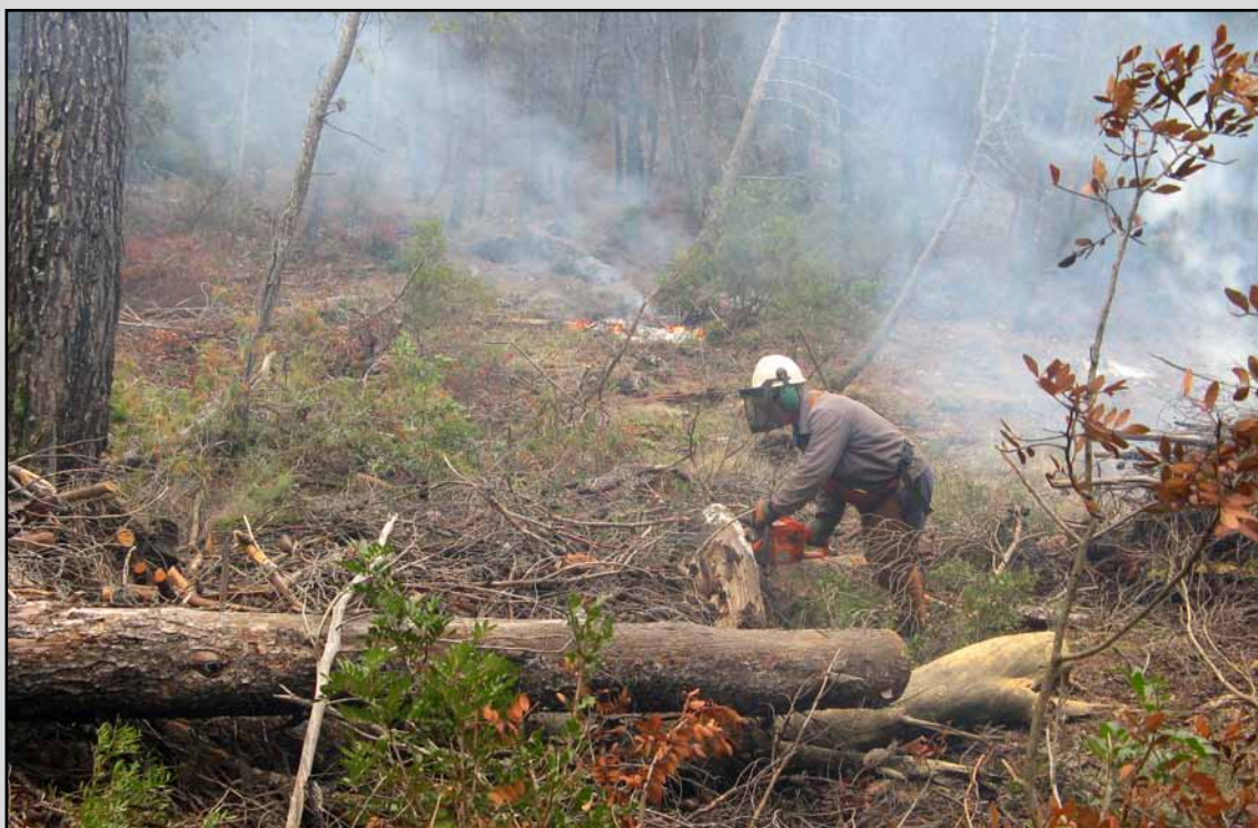
Peón especialista realizando tronzado con motosierra en el T.M. Santiago-Pontones (Jaén). (Obra 06_JA_226_5_3 Acondicionamiento de infraestructuras de prevención de incendios forestales en el "PN Cazorla, Segura y las Villas").
