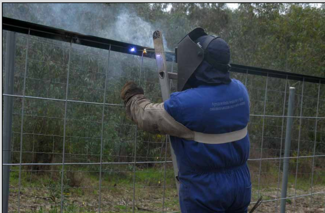
Soldadura de valla metálica en el T.M. Bonares (Huelva). (Obra 05_HU_323_1_Proyecto de restauración, mejora y puesta en valor del patrimonio rural
