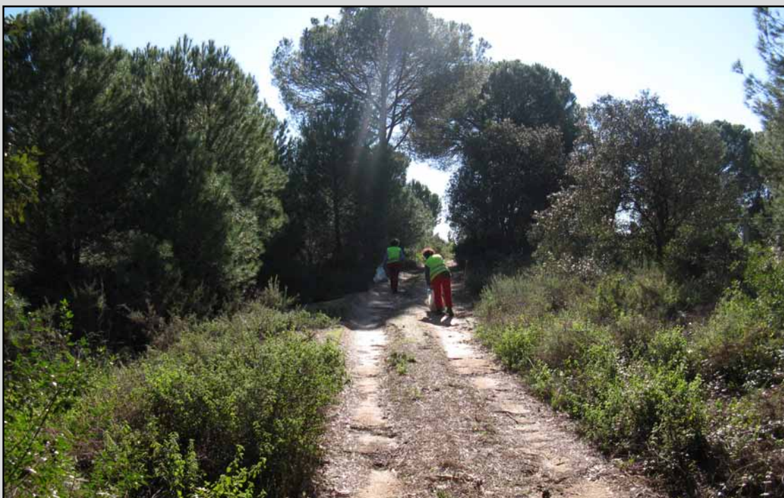
Recogida y apilado de residuos en el T.M. Villamanrique de la Condesa (Sevilla). (Obra 08_SE_226_5_5 Actuaciones selvícolas de prevención de incendios forestales y mejora de pinar en monte dehesa Boyal y El Chaparral de Villamanrique de la Condesa).
