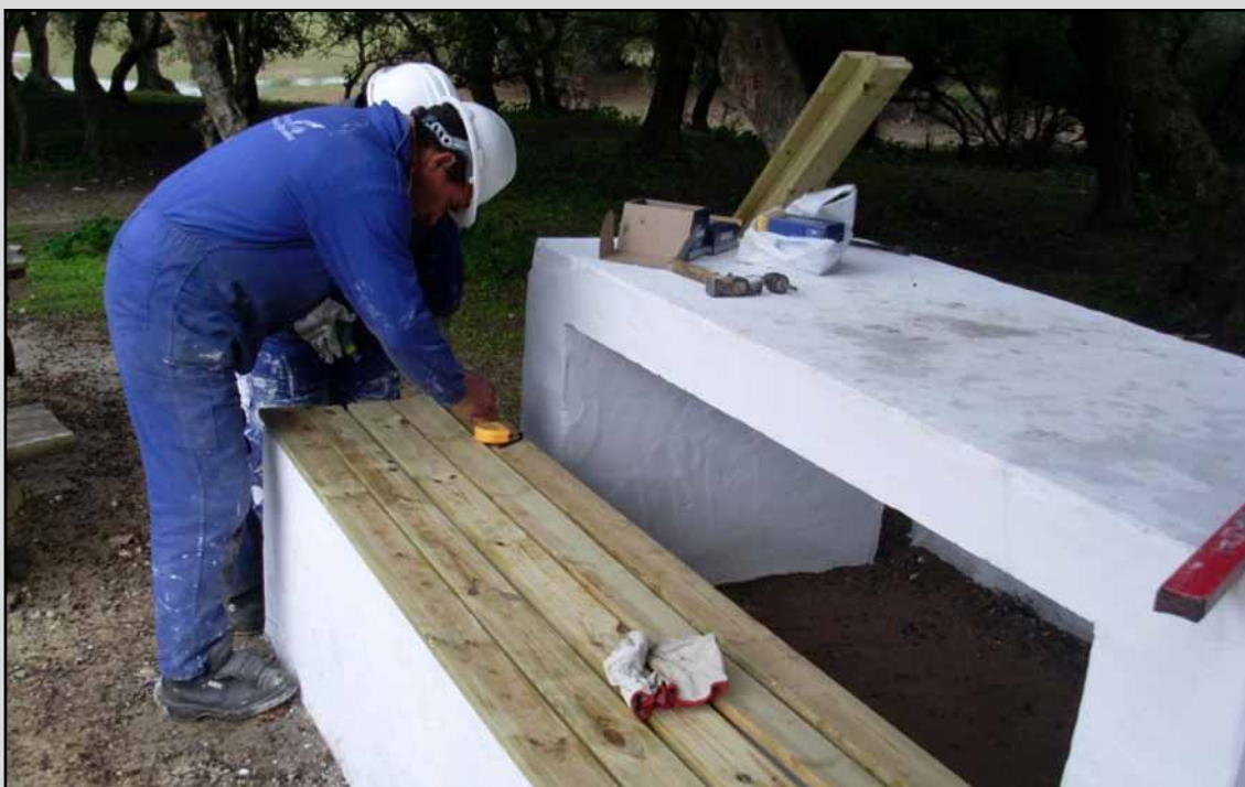
Construcción de banco en zona recreativa en el T.M. Benalup (Cádiz). (Obra 02_CA_323_1 Proyecto de restauración, mejora y puesta en valor del patrimonio rural en montes públicos de la provincia de Cádiz).
