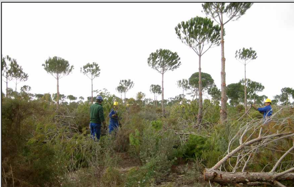
Recogida y apilado de residuos en el T.M. Bonares (Huelva). (Obra 05_HU_226_123_2 Actuaciones selvícolas y de prevención de incendios en montes de la provincia de Huelva).
