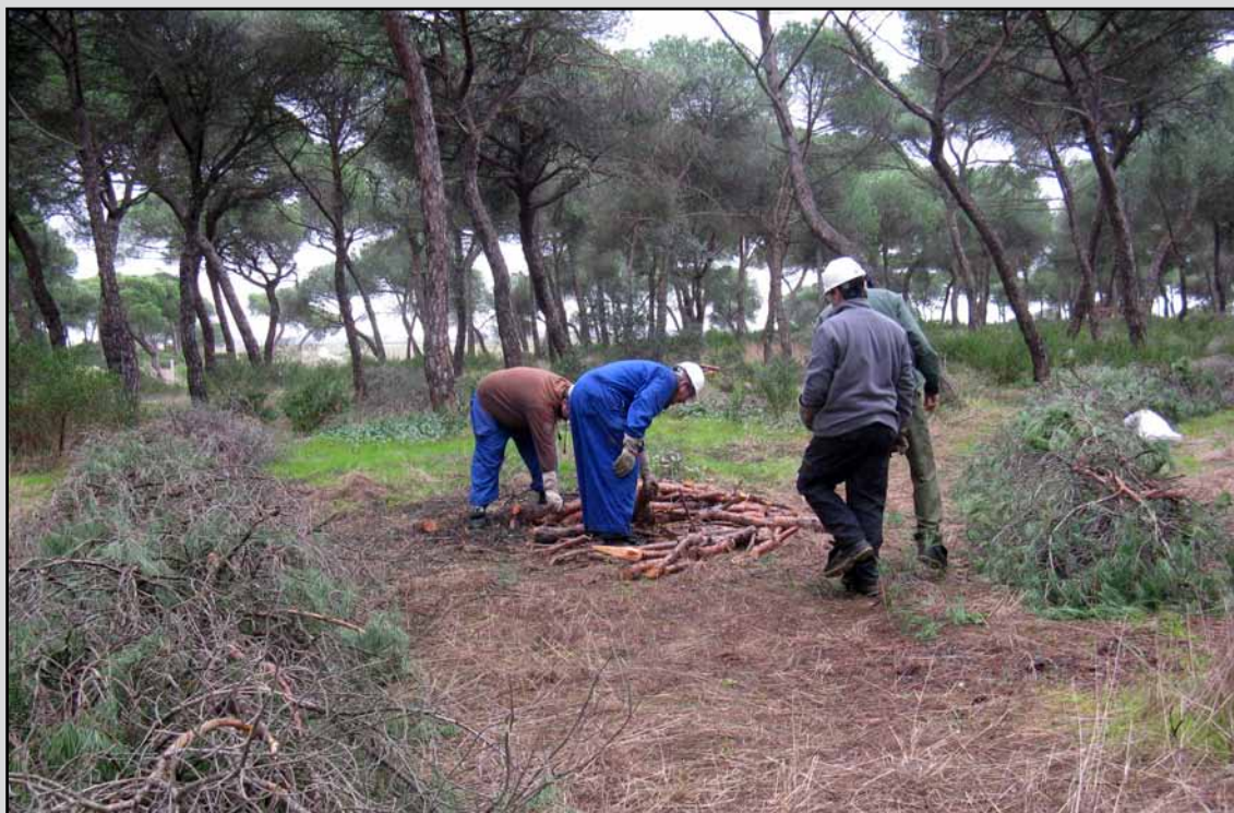
Recogida y apilado de madera en el T.M. Aljaraque (Huelva). (Obra 05_HU_227_123_1 Actuaciones para la conservación de los hábitats y mantenimiento de la biodiversidad en montes de la provincia de Huelva).
