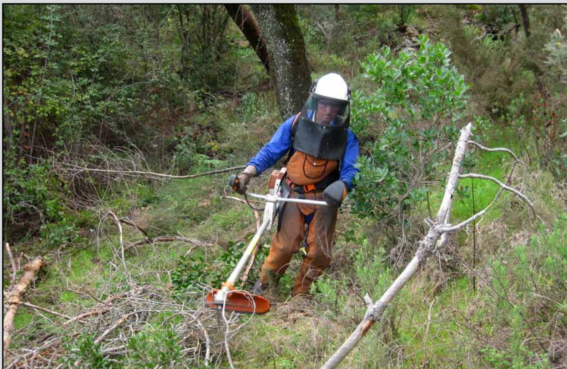
Roza de vegetación con motodesbrozadora en el T.M. La Granada de Río-Tinto (Huelva). (Obra 05_HU_226_123_2 Actuaciones selvícolas y de prevención de incendios en montes de la provincia de Huelva).
