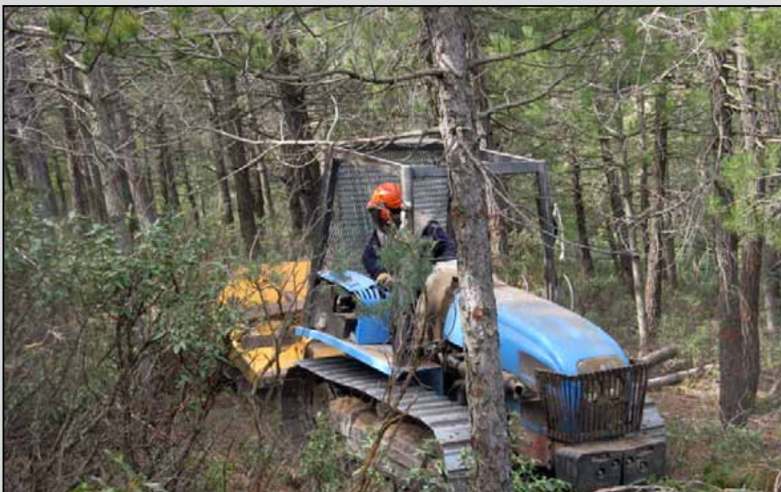
Eliminación de residuos con desbrozadora de cadenas en el T.M. Tahal (Almería). (Obra 01_AL_226_123_1 Tratamientos selvícolas preventivos y de mejora de los montes públicos de Sierra de Filabres).
