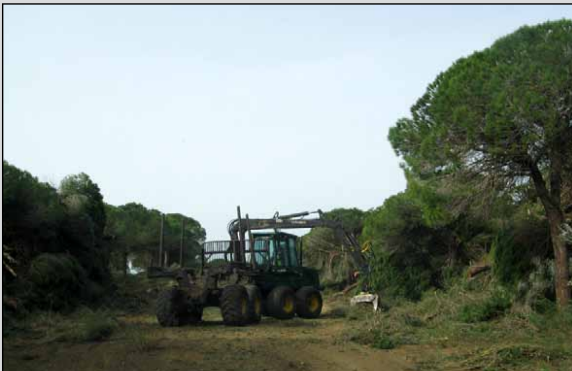
Saca de madera con autocargador en el T.M. Barbate (Cádiz). (Obra O2_CA_226_5_5 Actuaciones selvícolas de prevención de incendios, de mejora productora, de corrección hidrológica y restauración en montes públicos de Barbate).
