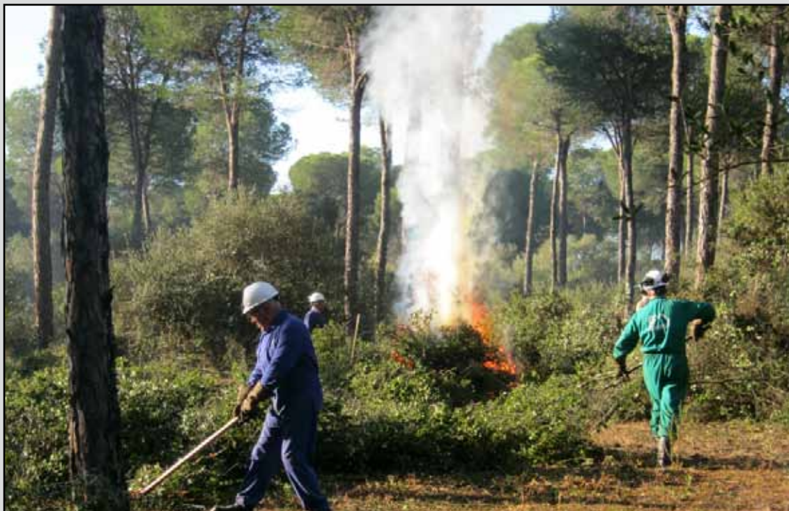
Quema controlada de residuos en el T.M. Puebla del Río (Sevilla). (Obra 08_SE_227_5_1 Mejora ambiental y diversificación productiva en montes públicos de Aznalcázar, La Puebla del Río y Villamanrique de la Condesa. Sevilla).
