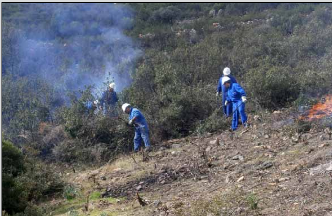
Quema controlada de residuos en el T.M. Santa Eufemia (Córdoba). (Obra 03_CO_226_123_3 Tratamientos selvícolas preventivos y de mejora de la masa en los montes La Sierra, Los Puntales, El Sordo y Alta Reina).
