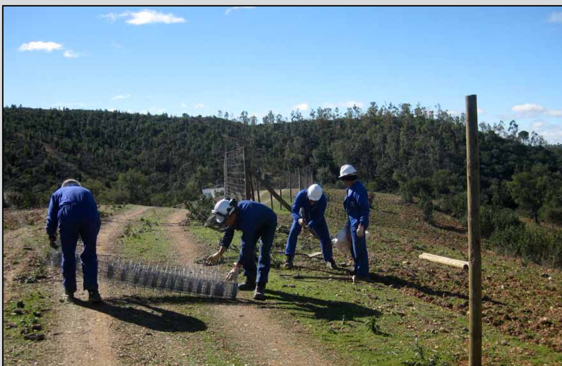
Cerramiento con malla en el T.M. Nerva (Huelva). (Obra 05_HU_227_4_1 Tratamientos selvícolas para mejora de hábitat de especies cinegéticas y silvestres).
