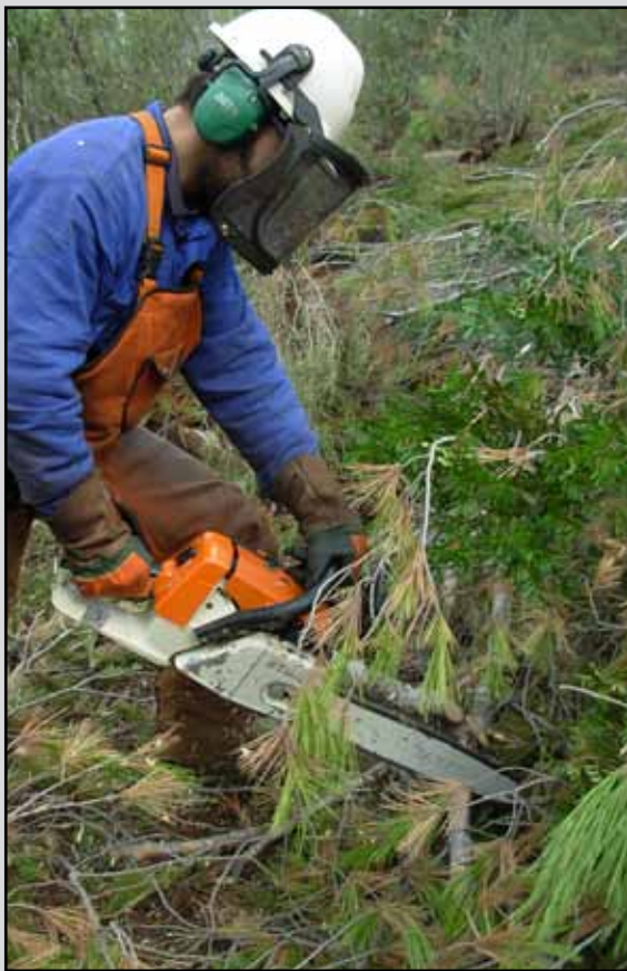
Desramado con motosierra en el T.M. Santiago-Pontones (Jaén). (Obra 06_JA_226_5_1 Actuaciones selvícolas de prevención de incendios, de mejora productora y restauración en el "P.N. Cazorla, Segura y las Villas". Sierra de Cazorla y las Villas).
