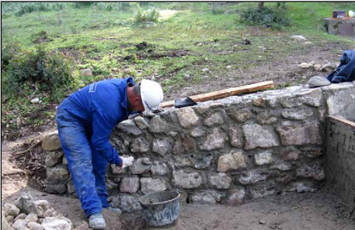
Restauración de abrevadero en el T.M. El Bosque (Cádiz). (Obra 02_CA_323_1 Proyecto de restauración, mejora y puesta en valor del patrimonio rural en montes públicos de la provincia de Cádiz).
