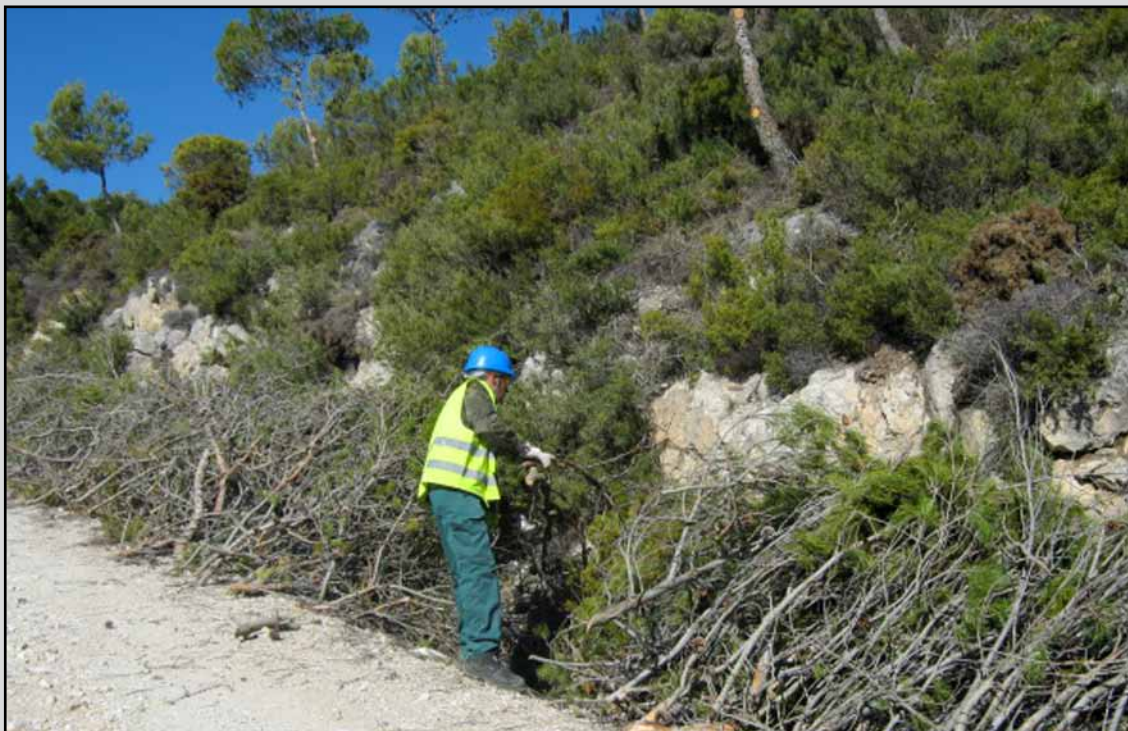
Apilado de residuos en el T.M. Huelma (Jaén). (Obra 06_JA_226_4_3 Actuaciones selvícolas de prevención de incendios, de mejora productora, de corrección hidrológica y restauración en Sierra Morena y Sierra Sur de Jaén).
