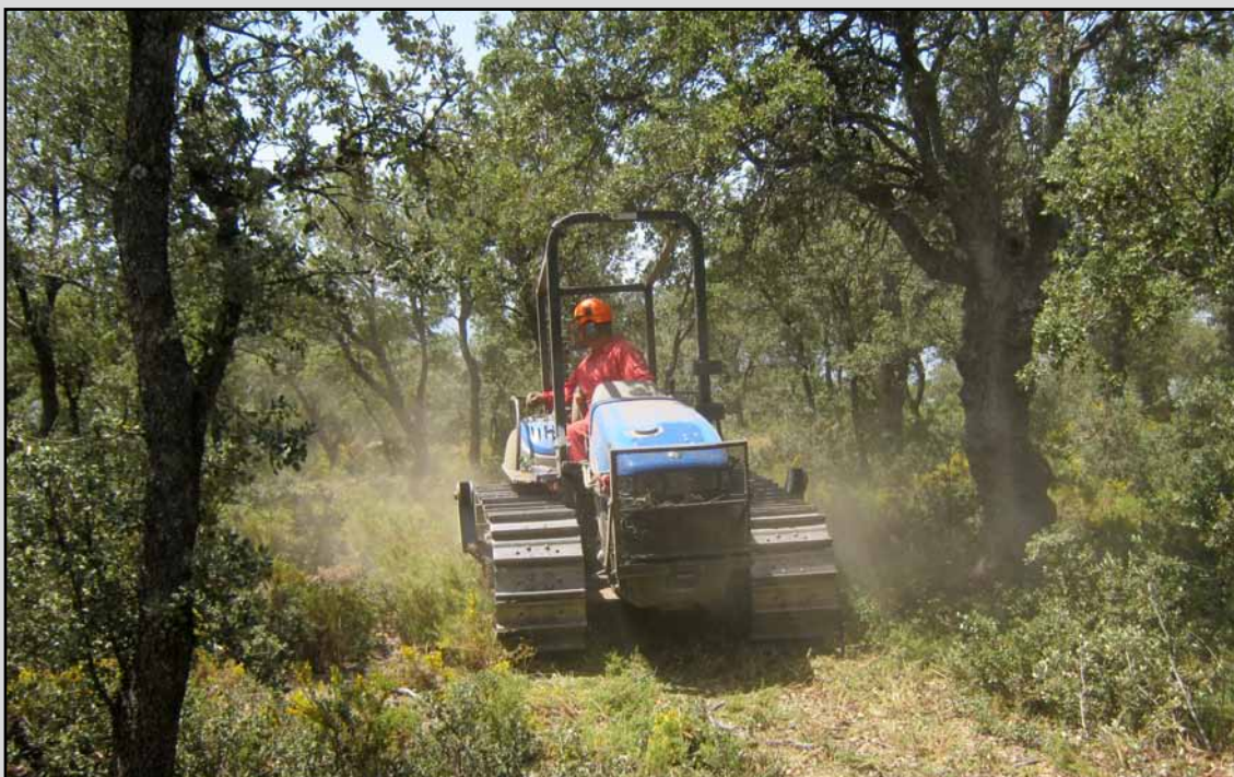
Desbroce con desbrozadora de cadenas en el T.M. Bayárcal (Almería). (Obra 01_AL_226_123_2 Tratamientos selvícolas preventivos y de mejora de los montes en Sierra Nevada (Almería) y Sierra de Gador).
