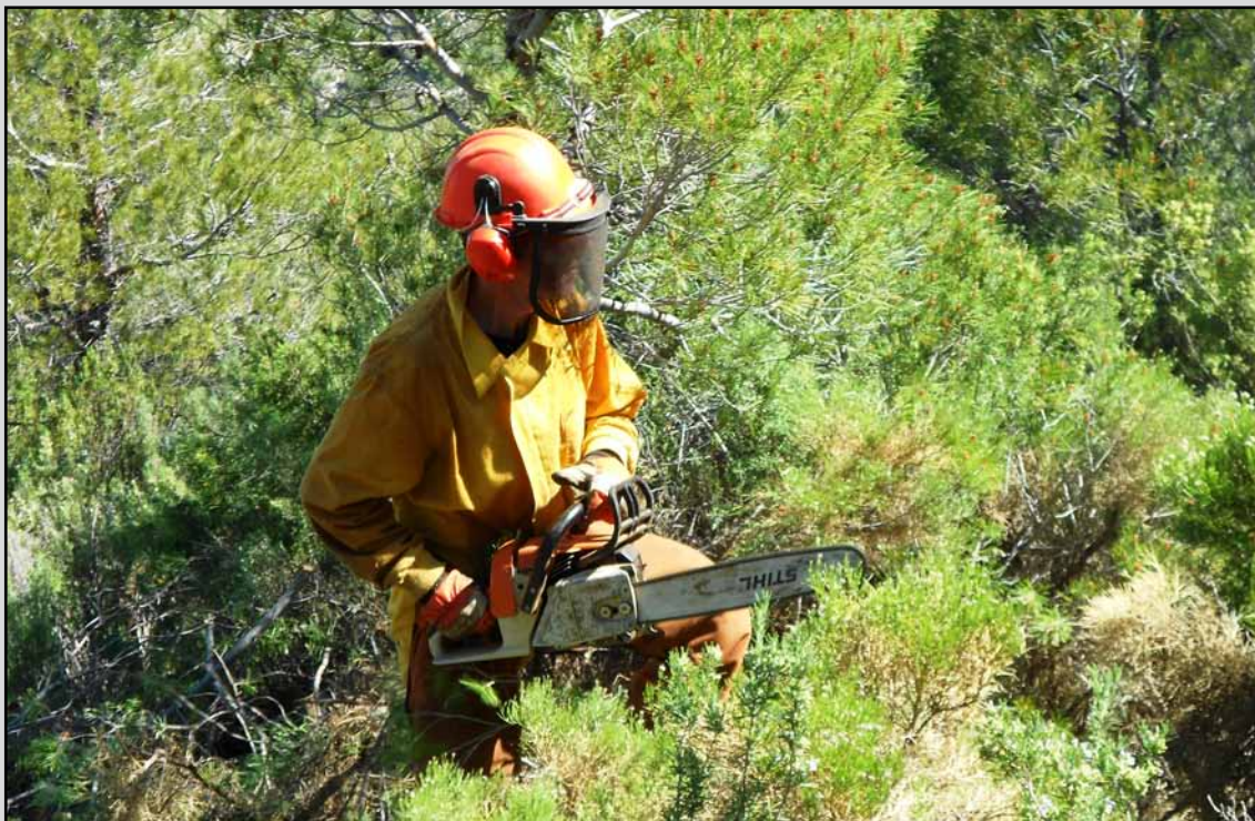
Apeo y poda con motosierra en el T.M. Iznalloz (Granada). (Obra 04_GR_226_5_2 TT.SS. de prevención de incendios forestales y de mejora de la capacidad productora de biomasa forestal de uso energético y de pastos en TT.MM. de las comarcas de Alhama, Los Montes y Loja en provincia de Granada).
