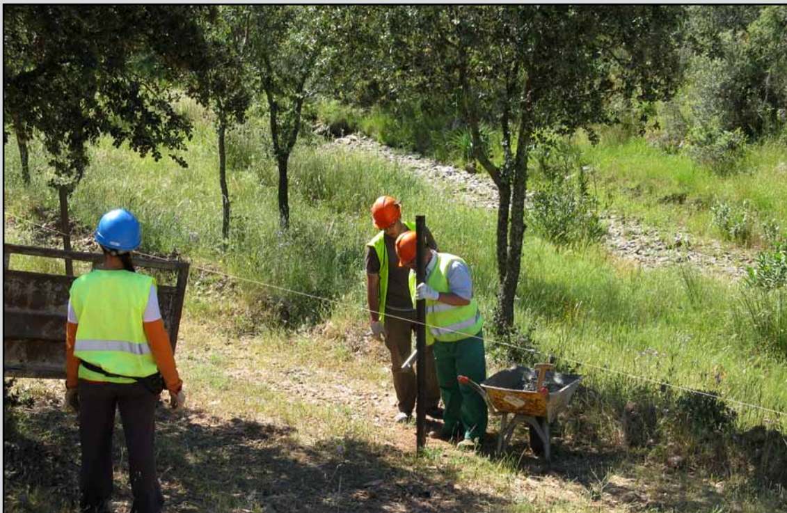
Colocación de cerramiento en el T.M. Almadén de la Plata (Sevilla). (Obra 08_SE_227_123_2 Mejora de hábitats de especies de fauna silvestre en el monte La Travesía en el término municipal de Almadén de la Plata. Sevilla).
