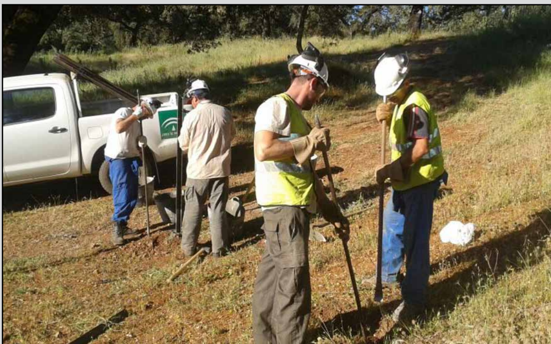
Colocación cerramiento en el T.M. Almadén de la Plata (Sevilla). (Obra 08_SE_227_123_1 Mejora de hábitats de especies cinegéticas en montes de Villanueva del Río y Minas, Alanís, Alcolea del Río, Almadén de la Plata, Coripe, Castillo de las Guardas, Madroño, San Nicolás, Sanlúcar la Mayor y Coria del Río. Sevilla).
