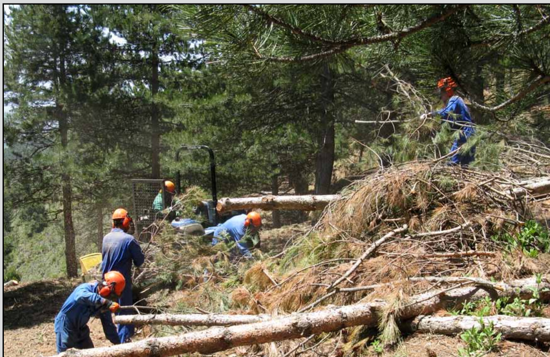
Astillado de residuos en el T.M. Canillas de Aceituno (Málaga). (Obra 07_MA_227_4_1 Mejora de habitats en la provincia de Málaga).
