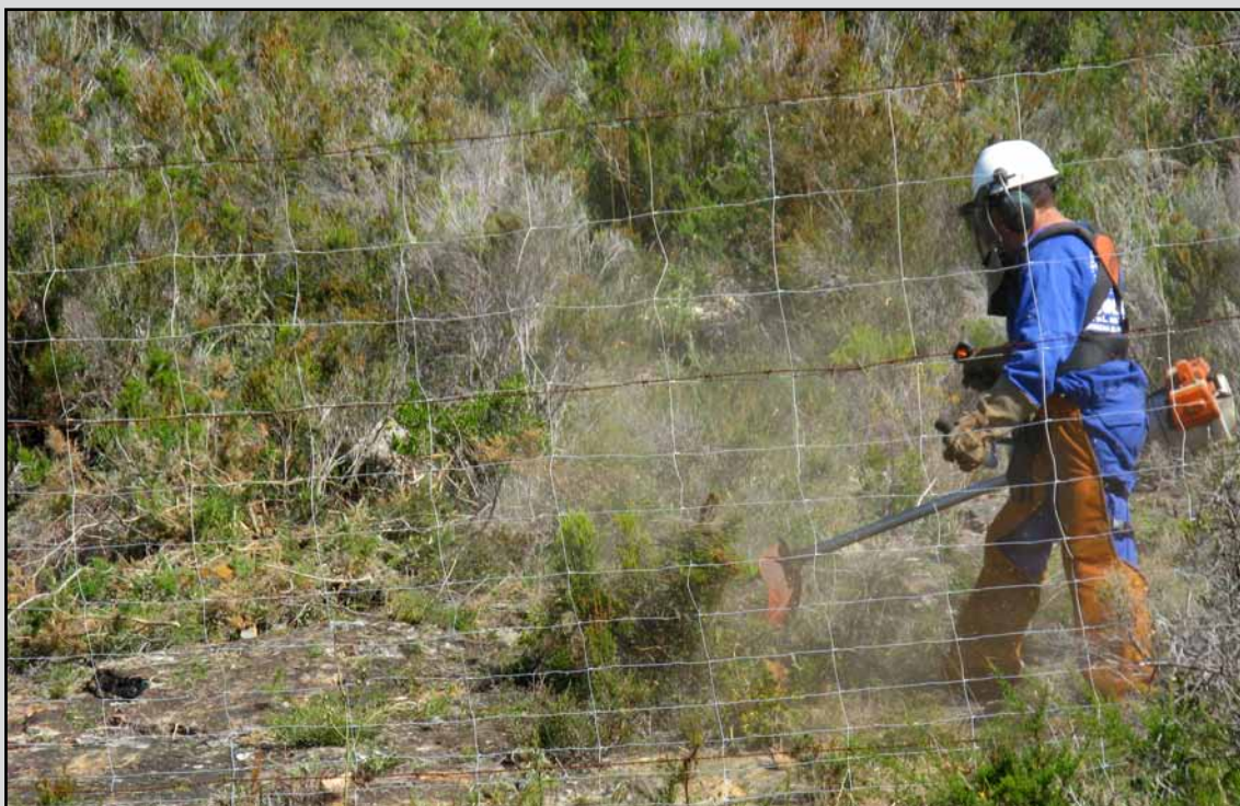
Desbroce con motodesbrozadora en el T.M. Los Barrios (Cádiz). (Obra 02_CA_226_F2_1 TT. SS. Preventivos y de mejora en restauraciones forestales en varios montes de los TT. MM. de Alcalá de los Gazules, Los Barrios y Tarifa. Cádiz).
