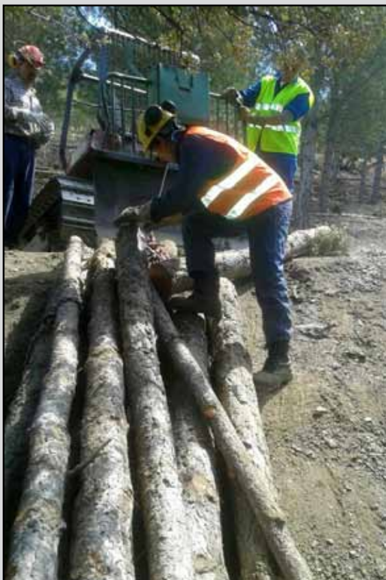
Enganche de madera en el T.M. Alpujarra de la Sierra (Granada). (Obra 04_GR_226_4_1 TT.SS. de prevención de incendios forestales y de mejora de la capacidad productora de biomasa forestal de uso energético y de pastos en el E.N. de Sierra Nevada y en el P.N. Sierras de Tejeda, Alhama y Almirajara. Provincia de Granada).
