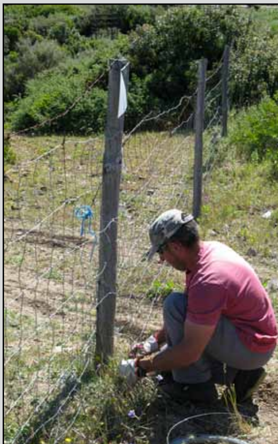
Reparación cerramiento en el T.M. Cortes de la Frontera (Málaga). (Obra 07_MA_227_5_1 Actuaciones mejora de habitats y adecuación de infraestructuras de uso público en montes públicos de Málaga).
