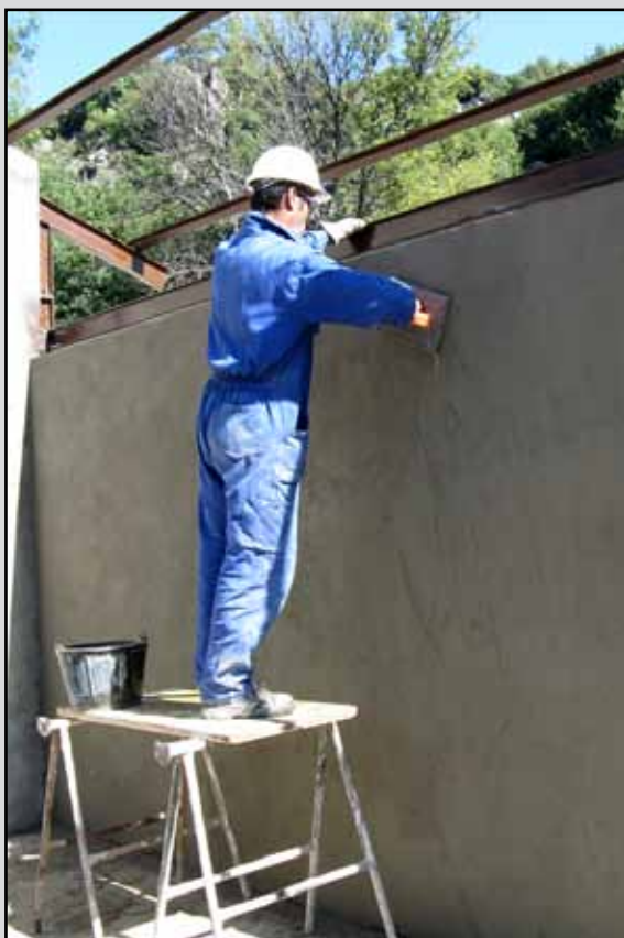
Trabajos de albañilería en el T.M. Grazalema (Cádiz). (Obra 02_CA_323_F2 Proyecto de restauración, mejora y puesta en valor del patrimonio rural en MM.PP. de la provincia de Cádiz).
