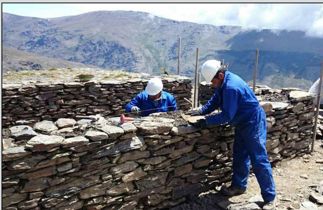
Ejecución de muro de mampostería en el T.M. Trevélez (Granada). (Obra 04_GR_323_1 Proyecto de restauración, mejora y puesta en valor del patrimonio rural en montes públicos de la provincia de Granada).
