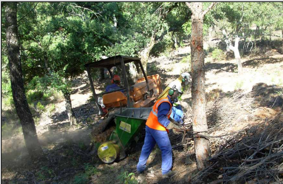
Astillado de residuos en el T.M. Santa Elena (Jaén). (Obra 06_JA_226_123_2 Actuaciones selvícolas de prevención de incendios, de mejora productora, de corrección hidrológica y restauración en Sierra Morena de Jaén).
