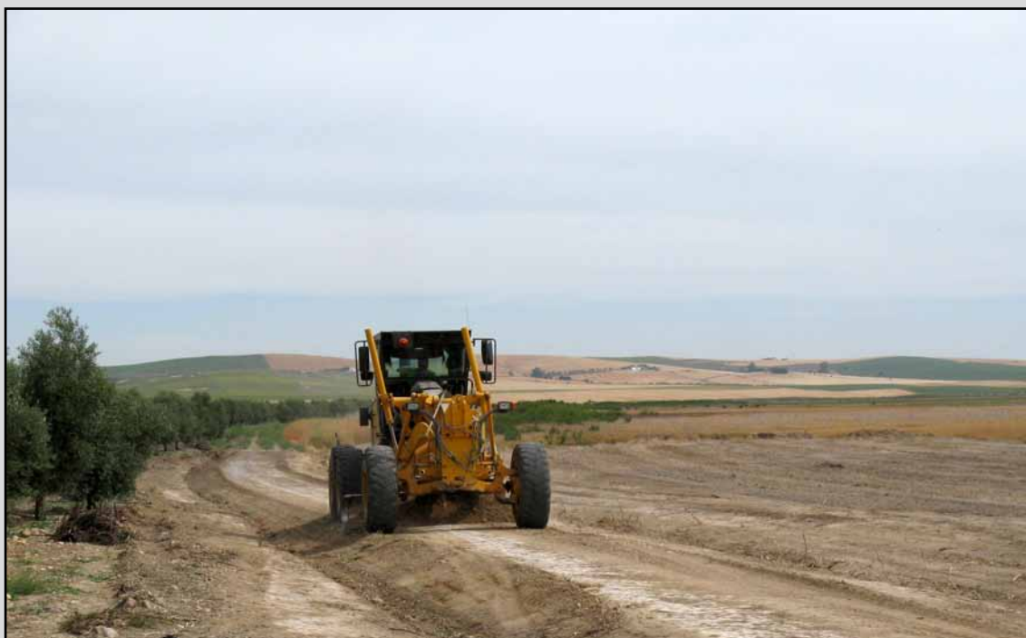
Apertura, refino y planeo de cunetas en el T.M. Écija (Sevilla). (Obra 08_SE_227_4_1 Mejora de habitats de especies cinegéticas en montes públicos de Morón de la Frontera, Écija y Osuna. Sevilla).
