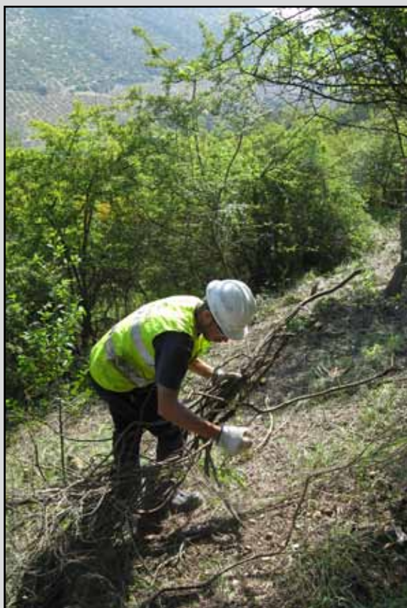
Recogida y apilado de residuos en el T.M. Cabra (Córdoba). (Obra 03_CO_226_4_1 Tratamientos selvícolas preventivos contra incendios forestales en los montes Santa Rita y Sierra y Lanchar. Córdoba).
