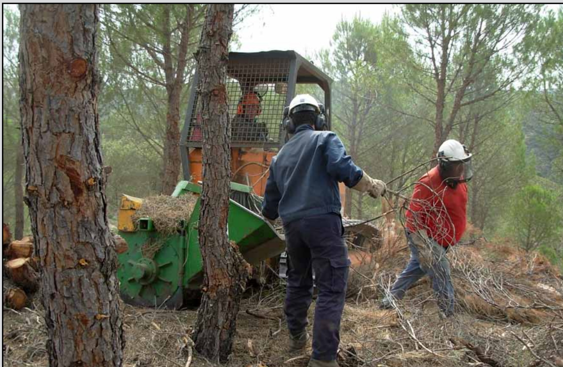
Astillado de residuos en el T.M. Castellar (Jaén). (Obra 06_JA_226_5_4 Actuaciones selvícolas de prevención de incendios, de mejora productora, de corrección hidrológica y restauración en Sierra Morena de Jaén).
