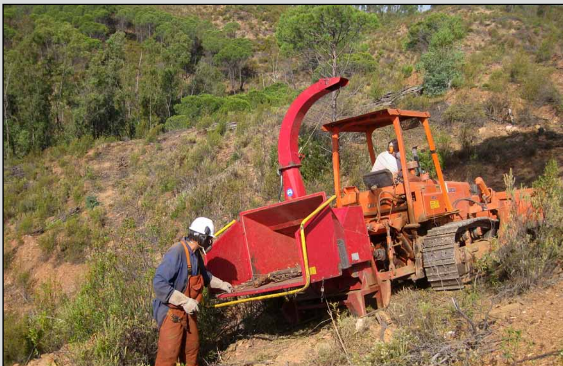
Astillado de residuos en el T.M. Niebla (Huelva). (Obra 05_HU_226_F2_3 Mejora del potencial biológico y forestal tras incendio en monte público Baldíos de Niebla. Huelva).
