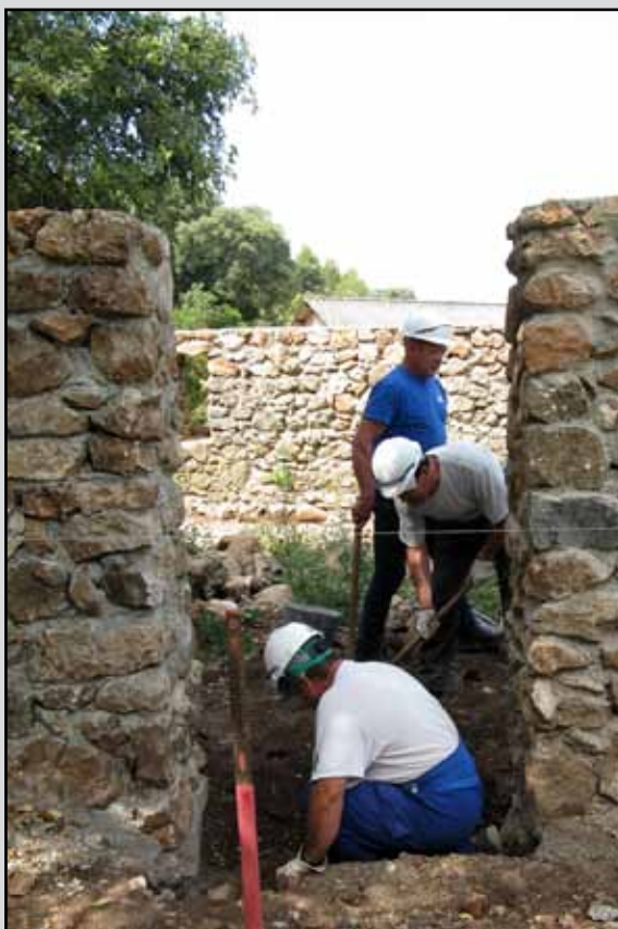
Excavación manual en el T.M. El Bosque (Cádiz). (Obra 02_CA_323_1 Proyecto de restauración, mejora y puesta en valor del patrimonio rural en montes públicos de la provincia de Cádiz).
