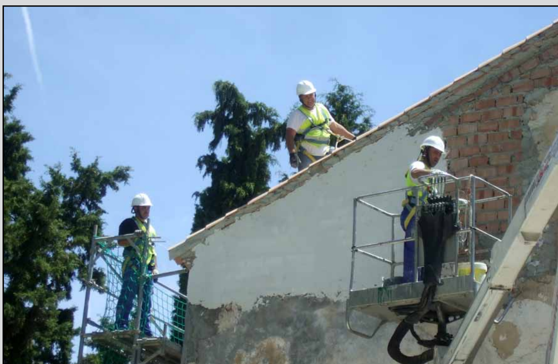
Enfoscado de fachada en el T.M. Arenas del Rey (Granada). (Obra 04_GR_323_3 Proyecto básico y de ejecución de restauración, mejora y puesta en valor del patrimonio rural en la finca la Resinera, T.M. Arenas del Rey. Granada).
