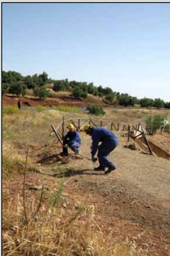
Colocación de valla de madera en el T.M. Linares (Jaén). (Obra 06_JA_227_F2 Actuaciones de conservación de flora y fauna en varias comarcas de la provincia de Jaén).
