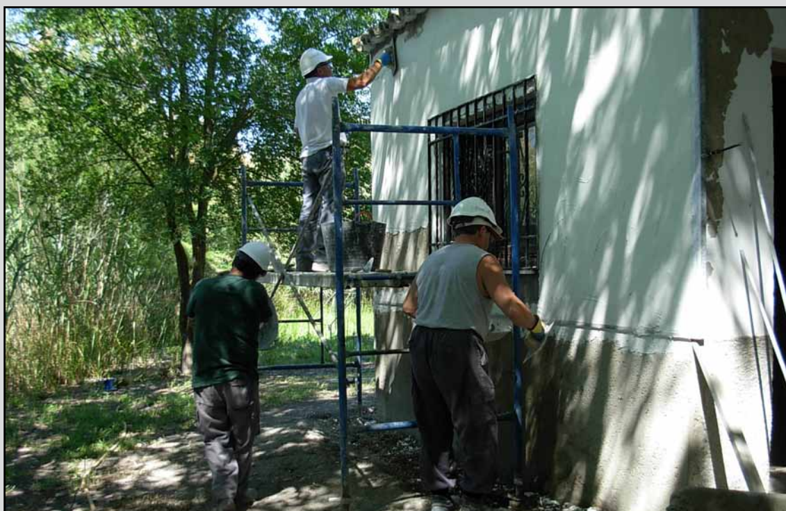
Enfoscado y enlucido de pared en el T.M. Aguilar de la Frontera (Córdoba). (Obra 03_CO_323_F2 Restauración, mejora y puesta en valor del patrimonio rural en montes públicos de la provincia de Córdoba. Fase II).
