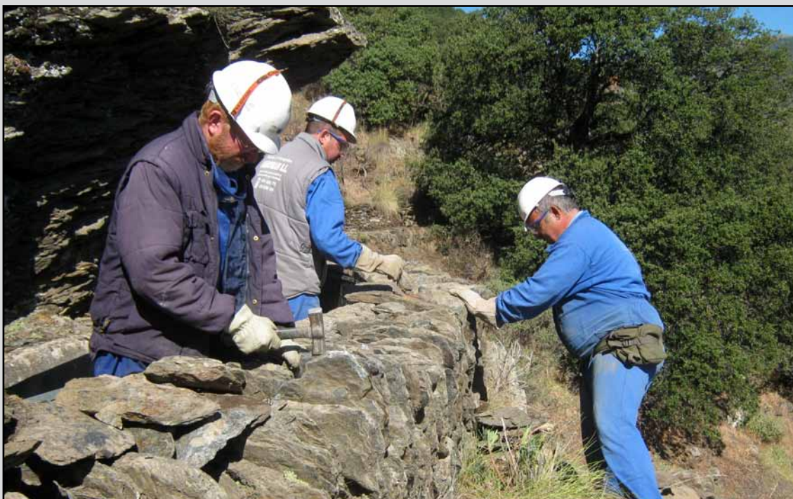
Acondicionamiento de acequia de careo en el T.M. Ohanes (Almería). (Obra 01_AL_227_123_1 Restauración de acequias de careo y terrenos forestales degradados por una antigua ladrillera en Almería).
