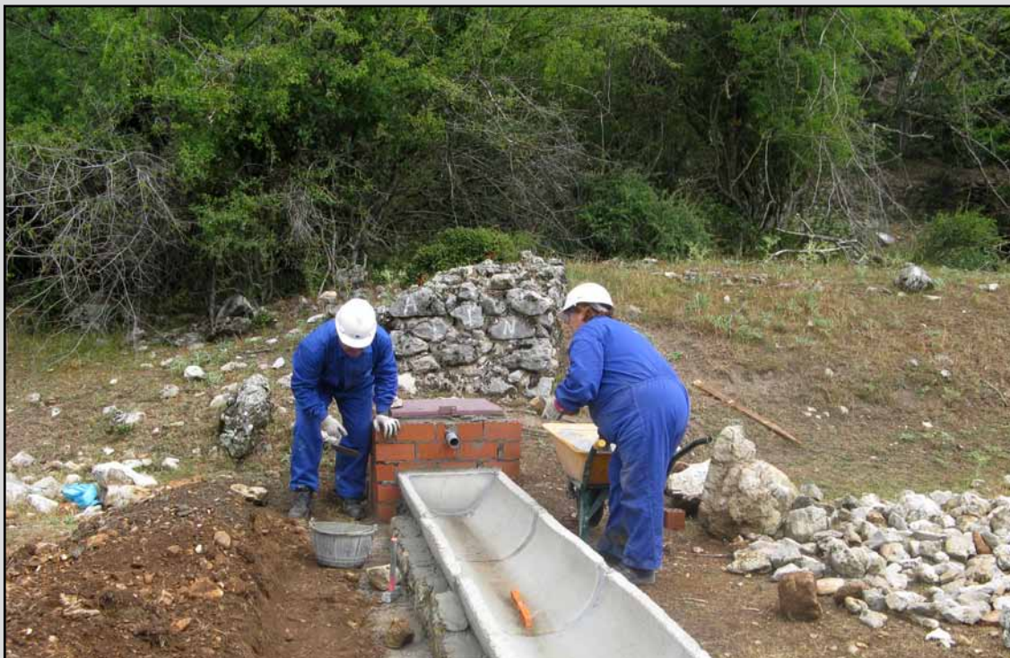
Restauración y mejora de canalización de un abrevadero en el T.M. Cazorra (Jaén). (Obra 06_JA_323_1 Proyecto de restauración, mejora y puesta en valor del patrimonio rural en montes públicos de la provincia de Jaén).
