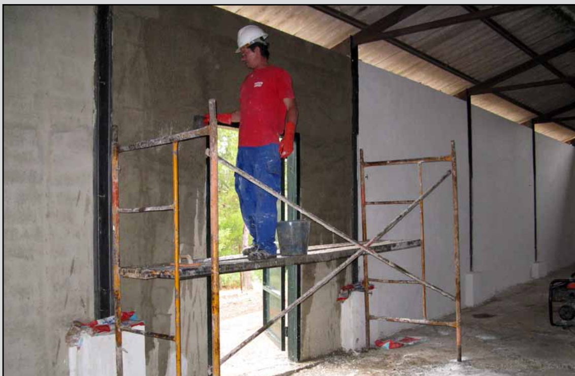
Enfoscados, guarnecidos y enlucidos en nave ganadera en monte Jerre en el T.M. Coripe (Sevilla). (Obra 08_SE_323_1 Proyecto de restauración, mejora y puesta en valor del patrimonio rural en montes públicos de la provincia de Sevilla).
