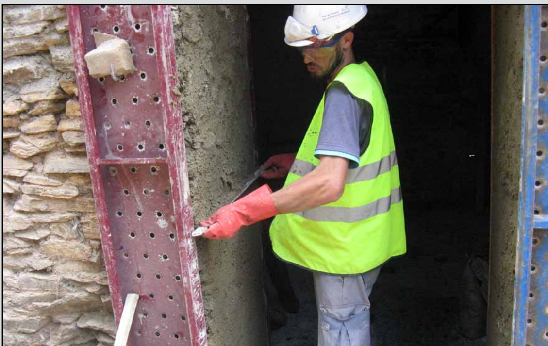
Enlucido de fachada en arreglo de apriscos en el T.M. Velefique (Almería). (Obra 01_AL_323_1 Proyecto de restauración, mejora y puesta en valor del patrimonio rural en montes públicos de la provincia de Almería).
